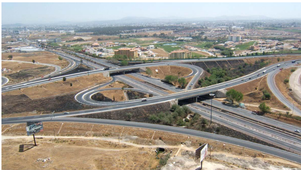
Vista del cruce del periférico y la vía Atlixcáyotl, al surponiente de la ciudad de Puebla Fuente: Espinoza Servín (2007).
