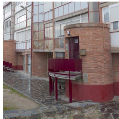
Volumen exterior del portal
