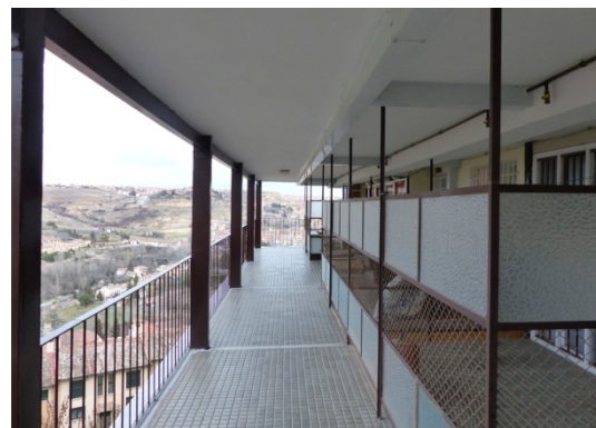
Aspecto del cerramiento de los tendederos
