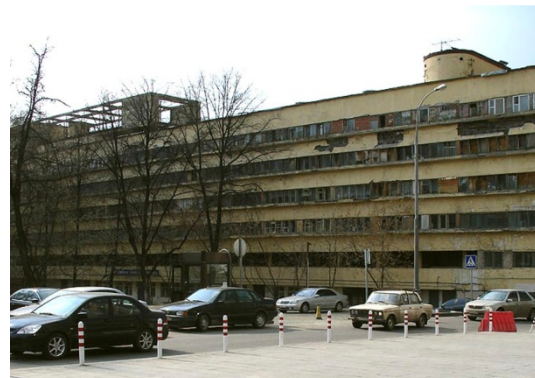
El edificio Narkomfin en la actualidad (Fuente: wikiarquitectura.com Fecha 14/06/2017)
