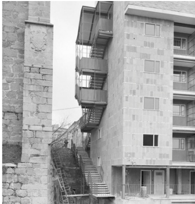
9. Núcleo de escaleras bloque I
