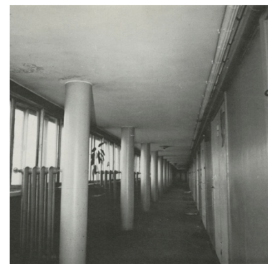
Núcleo de comunicación. Estado original (Fuente: charnel-house.org Fecha 14/06/2017)
