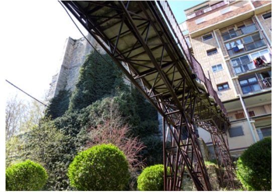
8. Espacio libre bajo la pasarela de conexión
