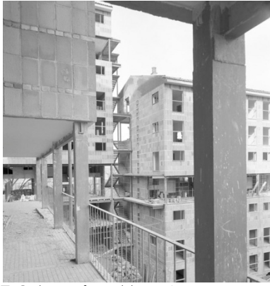
7. Galería inferior bloque I
