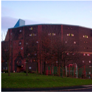
Fachada exterior del bloque perimetral. (Fuente: wikiead.pucv.cl Fecha 18/06/2017)
