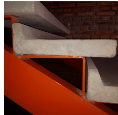
Imagen de detalle de la escalera
