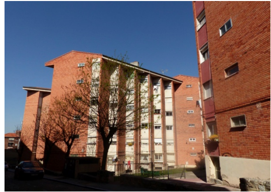
2. Vista este del conjunto
