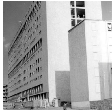
Imagen del bloque en construcción 1960 (Fuente: Fernández 2006 Fecha 18/06/2017)
