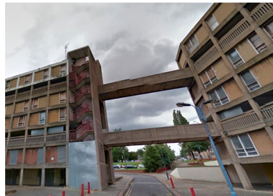
Conexión entre edificios y comunicación vertical (Fuente: google street view Fecha 18/06/2017)
