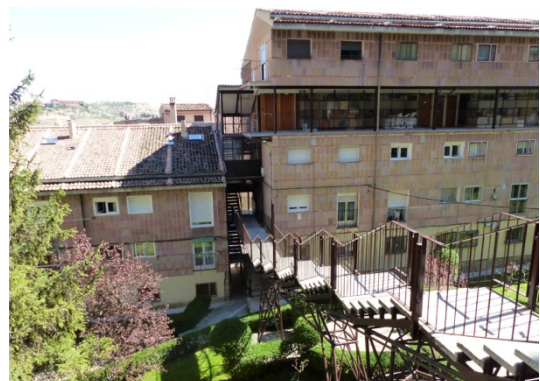
6. Pasarela de conexión entre bloques
