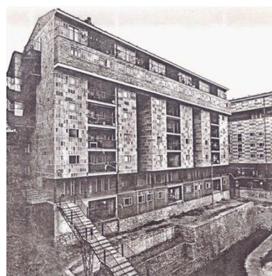
18. Bloque I y pasarela de conexión central
