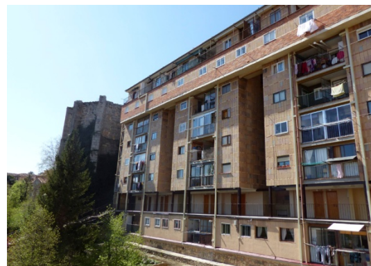
Estado actual del bloque I
