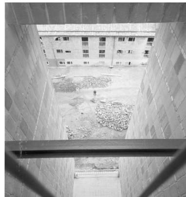
16. Patio exterior bloque I
