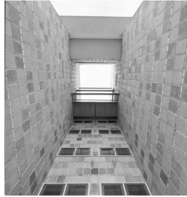
14. Patio exterior bloque I
