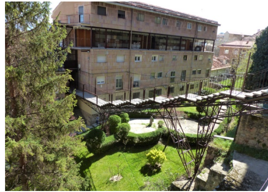
Pasarela central de conexión
