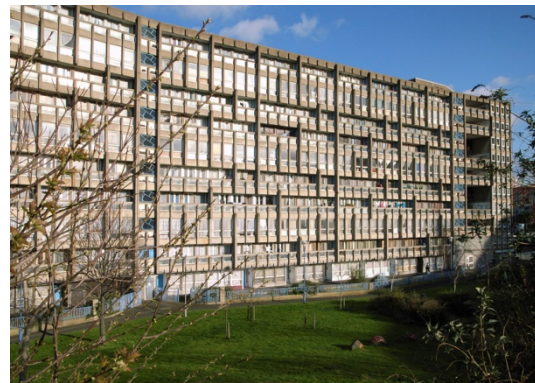
Conjunto Robin Hood Gardens (Fuente: archidaily.com Fecha 18/06/2017)
