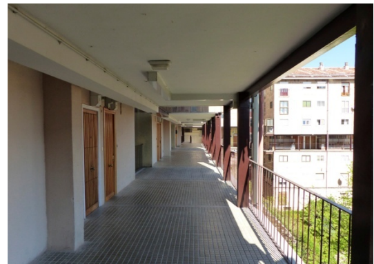
10. Galería inferior bloque I
