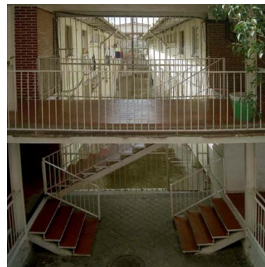
Pasarelas y núcleos verticales (Fuente: docomomoiberico.com Fecha 16/06/2017)
