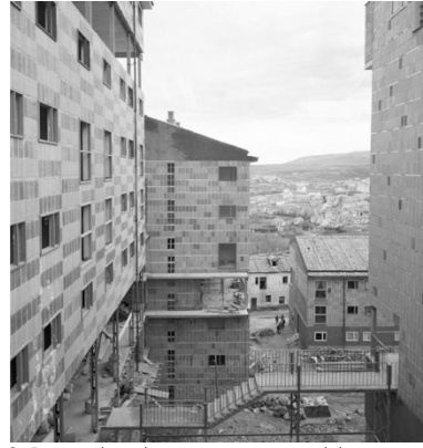
8. Pasarelas de conexión entre bloques
