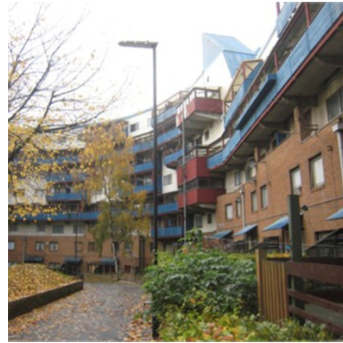
Fachada interior del bloque perimetral. (Fuente: sarahglynn.net Fecha 18/06/2017)
