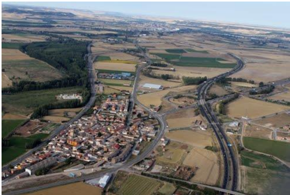
Imagen 2: vista aérea del municipio de Magaz, Palencia. Fuente: google images.
