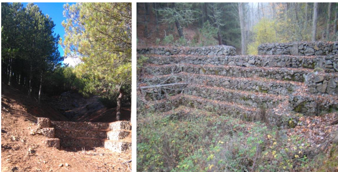
Figura 13. Ejemplos de los cambios de vegetación que se producen en las cárcavas intervenidas con diques gavionados.
