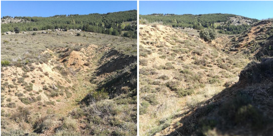
Figura 11. Erosión en la zona media-alta.
