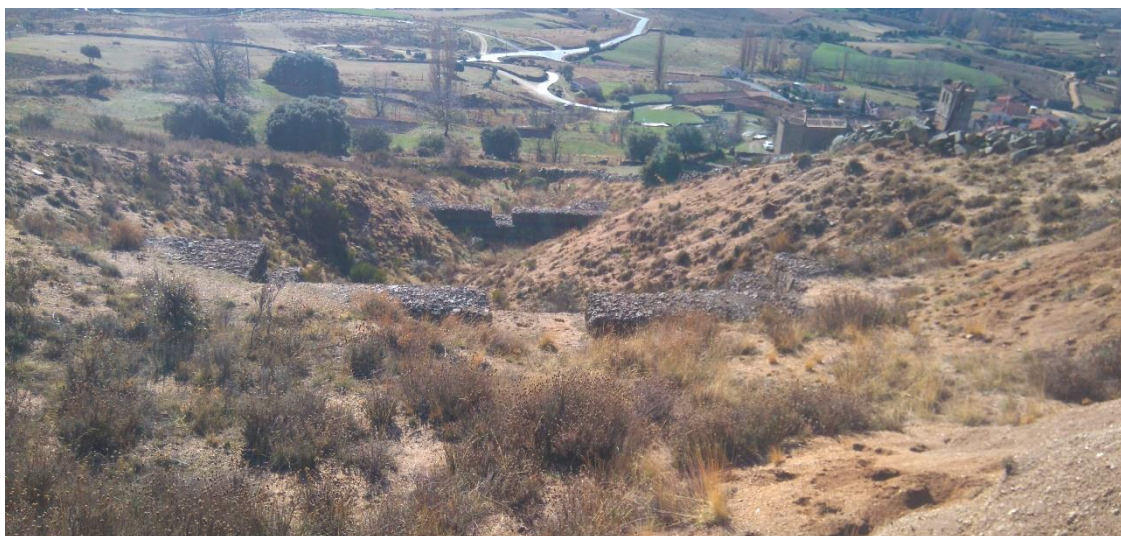
Figura 2. Diques en la zona de repoblación procedentes de la restauración de Azcarretazabal (1964).
