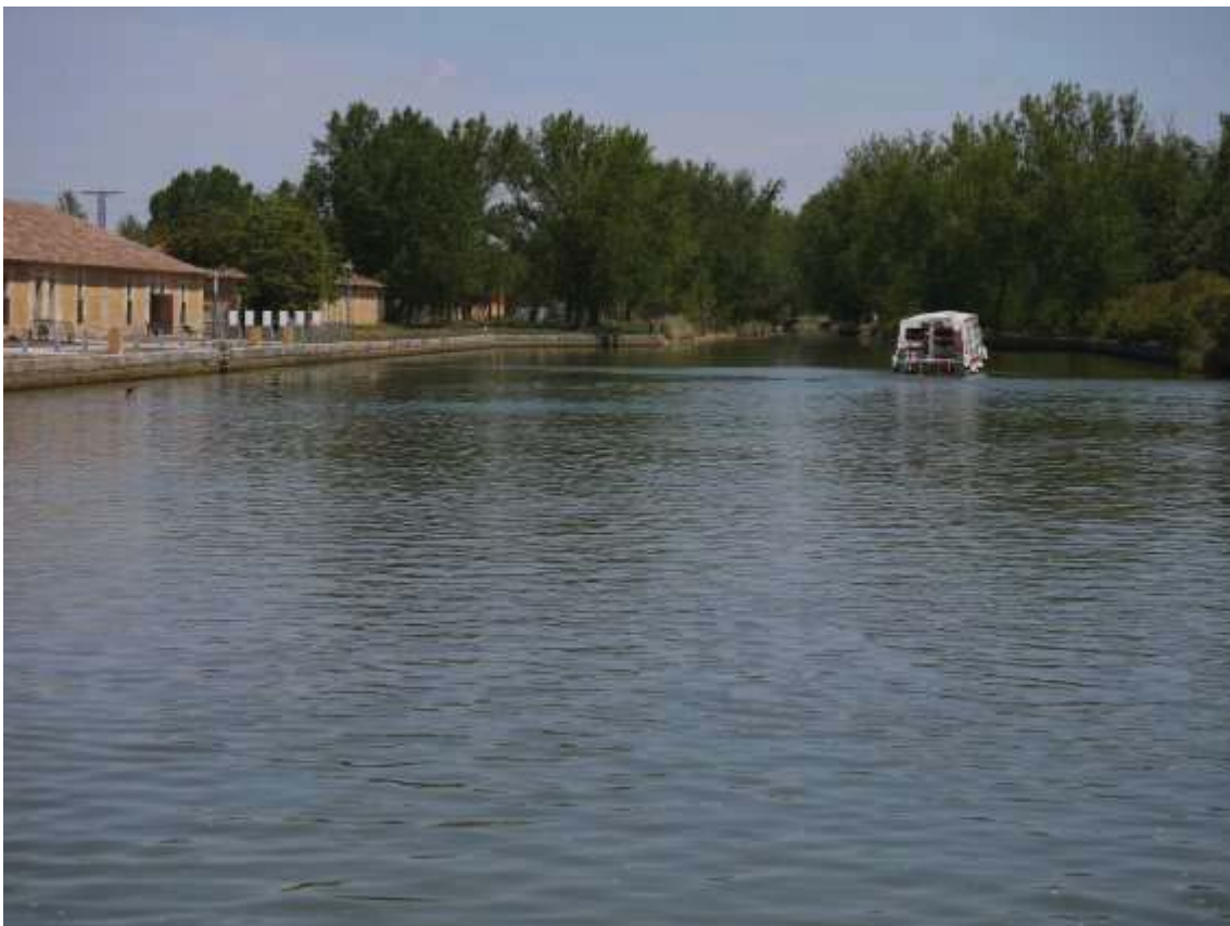
Fotografía 4: Dársena de Medina de Rioseco, situada en el casco urbano, y punto de partida del Ramal de Campos. Fuente: A. Gil.
