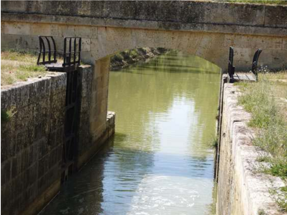
Fotografía 5: Infraestructuras en el Ramal de Campos. Fuente: A. Gil.
