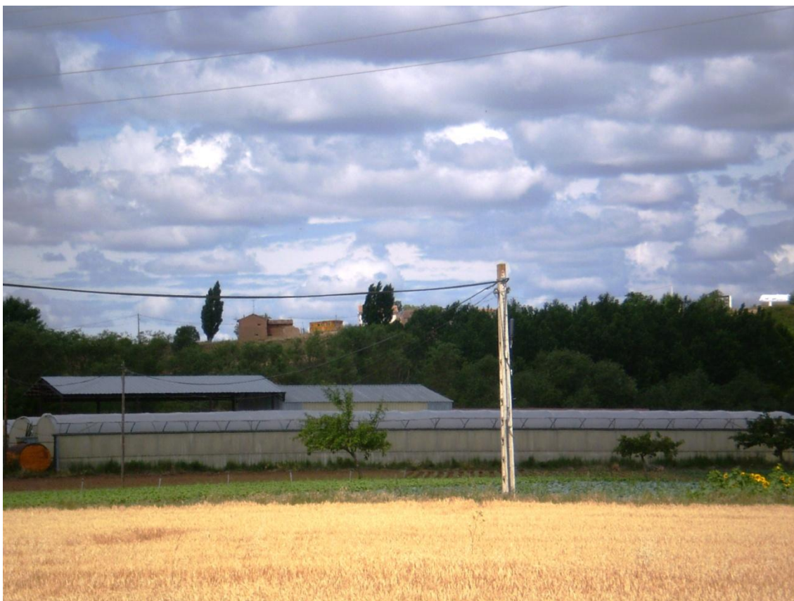
VISTA EXTERIOR DE LA VENTILACIÓN DEL INVERNADERO
