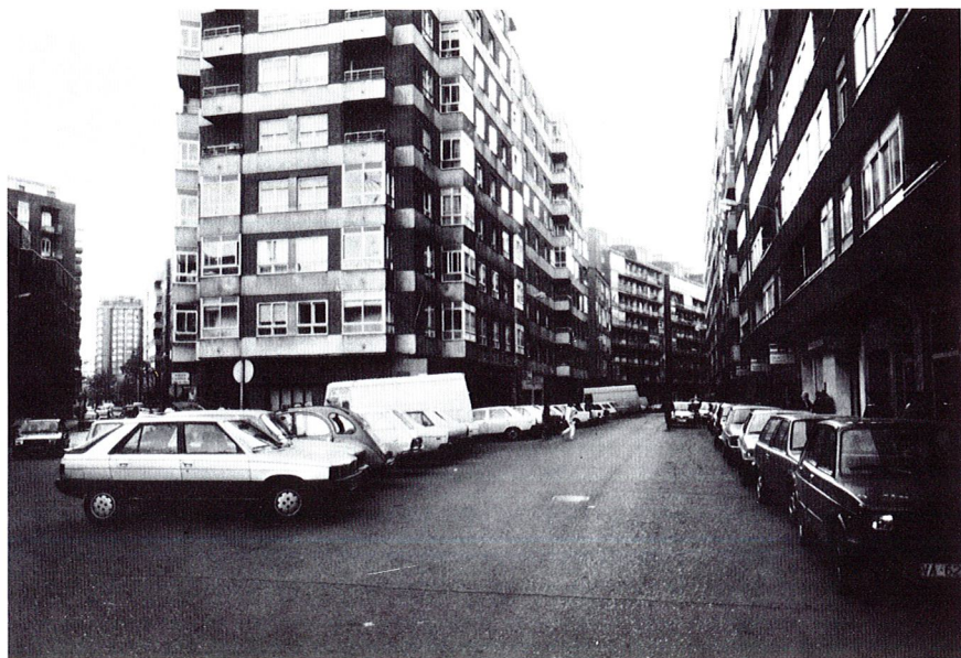
La calle San Quirce en su encuentro con la de Esteban García Chico. Un ejemplo de la ruptura del tejido tradicional y el cambio de escala en la edificación en el entorno de la muralla tradicional.
