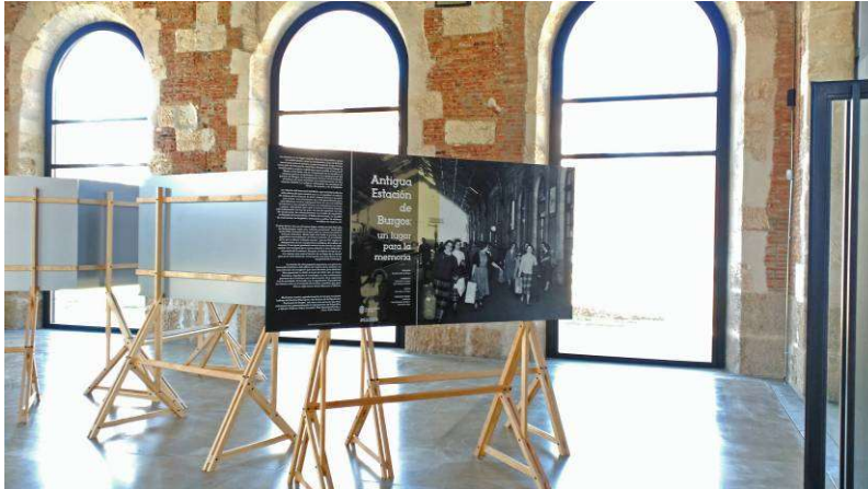
Figura 18. Imagen del interior del cuerpo occidental en el día de su inauguración. Obsérvese la carencia de revestimiento interior de los muros. (Fuente: Luis Santos, 2017).
