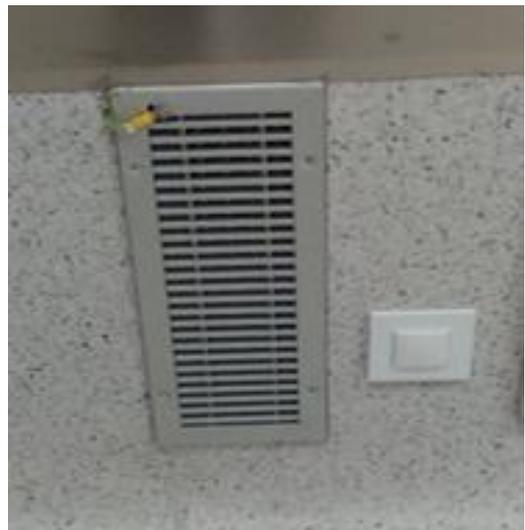
Figura 3.9: Rejilla de extracción inferior
