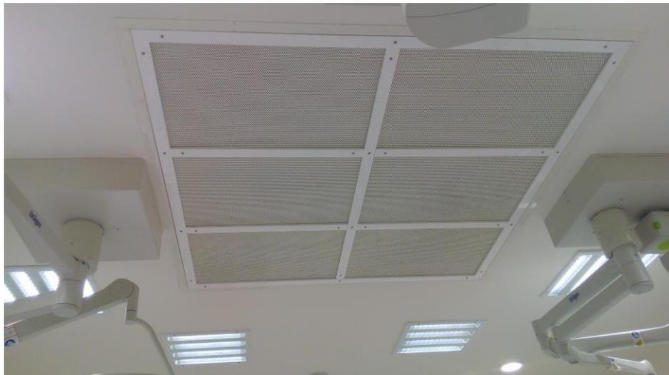
*Figura 3.8: Sistema de impulsión en el quirófano tipo A*
