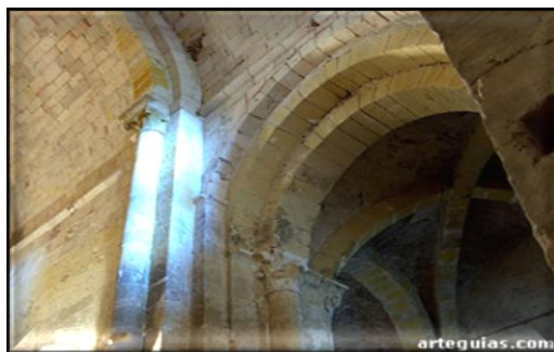
Figura 8. Pilares del interior de la fortaleza.
