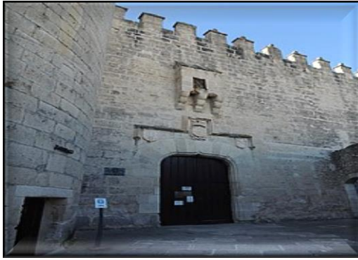
Figura 13. Puerta de la fachada del patillo de entrada
