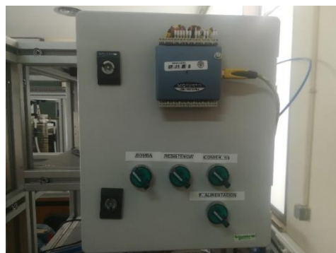
Figura 2 Tarjeta de adquisición de datos USB-1408FS-Plus en planta piloto
