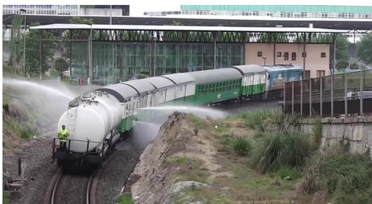
Ilustración 10: El denominado “tren herbicida” de Adif, realizando tratamiento de desbroce químico mediante la aplicación de herbicida. Fuente: Sintra S.A.
