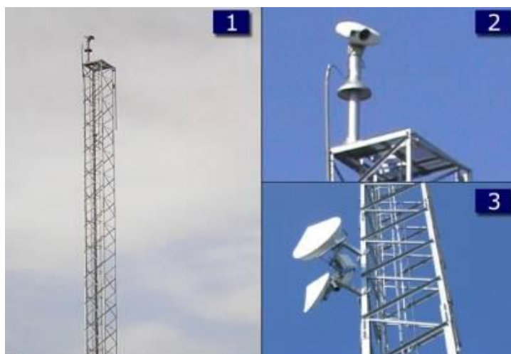
Ilustración2: Unidad de Vigilancia en funcionamiento (1), se encuentra las 24 horas en observación continua; las imágenes captadas por las cámaras (2) son enviadas vía radio enlace (3) desde la propia torre. Fuente: 6º Congreso Forestal Español, SECF.
