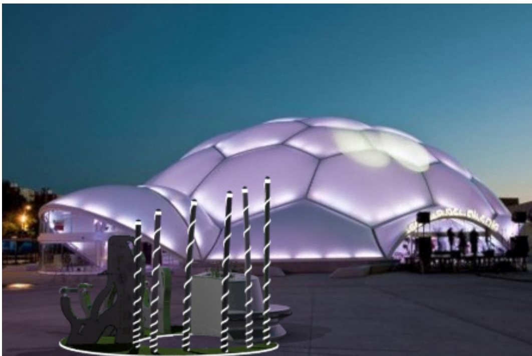
Diseño colocado en la Plaza del Milenio. Vista nocturna. Imagen de elaboración propia.
