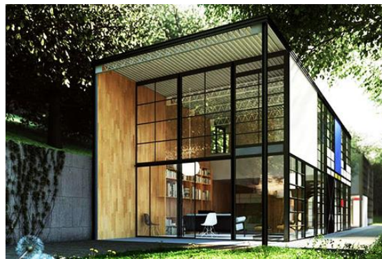
Ilustración 63: espacio protegido por la cubierta y el muro en la sala de estar de la CSH 8
