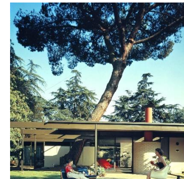
Ilustración 92: pino atravesando la cubierta de la CSH 20
