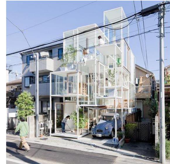
Ilustración 172: losas flotando de la Casa NA
