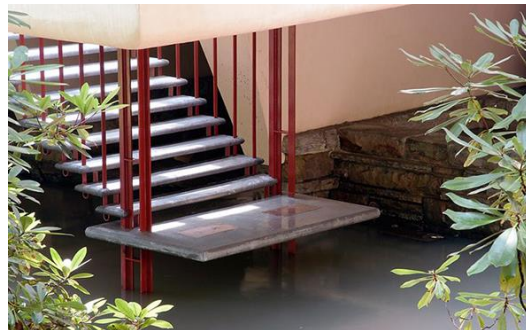
Ilustración 21: Escalera de acceso a la cascada
