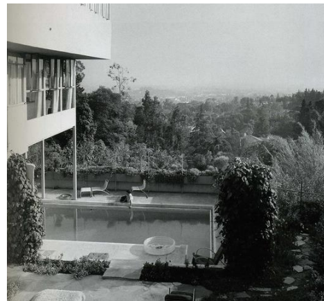
Ilustración 47: zona de la piscina
