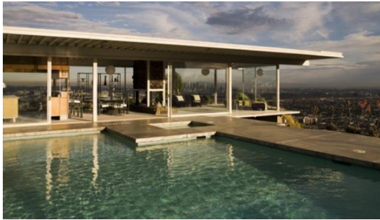
Ilustración 72: cubierta flotante de la CSH 22
