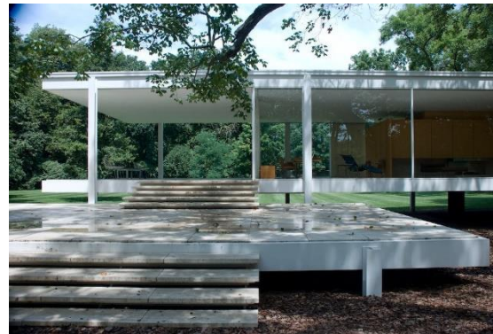
Ilustración 36: plataforma de acceso a la Casa Farnsworth
