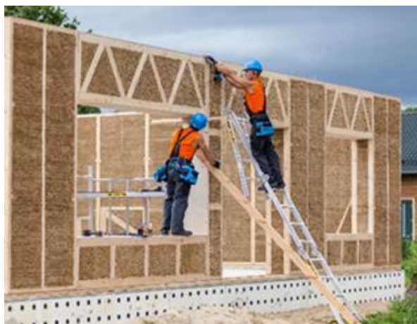
Figura 18 y 19. Técnicas tradicionales adaptadas a sistemas constructivos actuales. Entramado de Barro y paja
