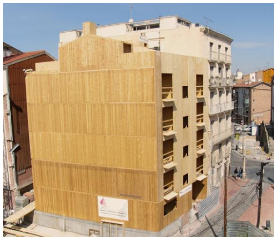
Figura 22. Bloque de viviendas realizado a partir de panel laminado de madera estructural. Fuente. Alter materia.
