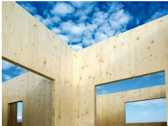
Figura 23. Montaje del panelado de madera lamina estructural
