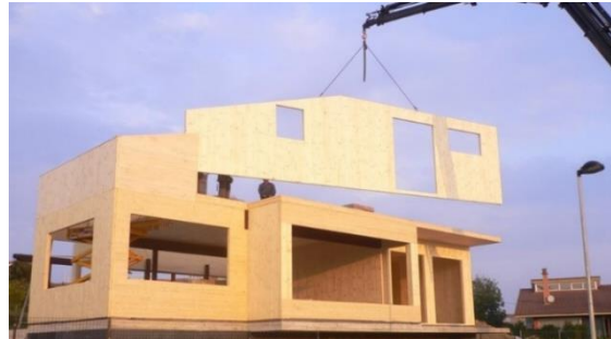
Figura 27. Proceso de montaje.
