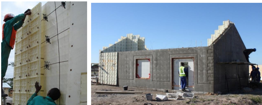
Figura 20 y 21. Construcción mediante el sistema Moladi. Fuente. Plataforma de Arquitectura.
