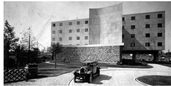
3. Pabellón Suizo (parte trasera), 1933.
