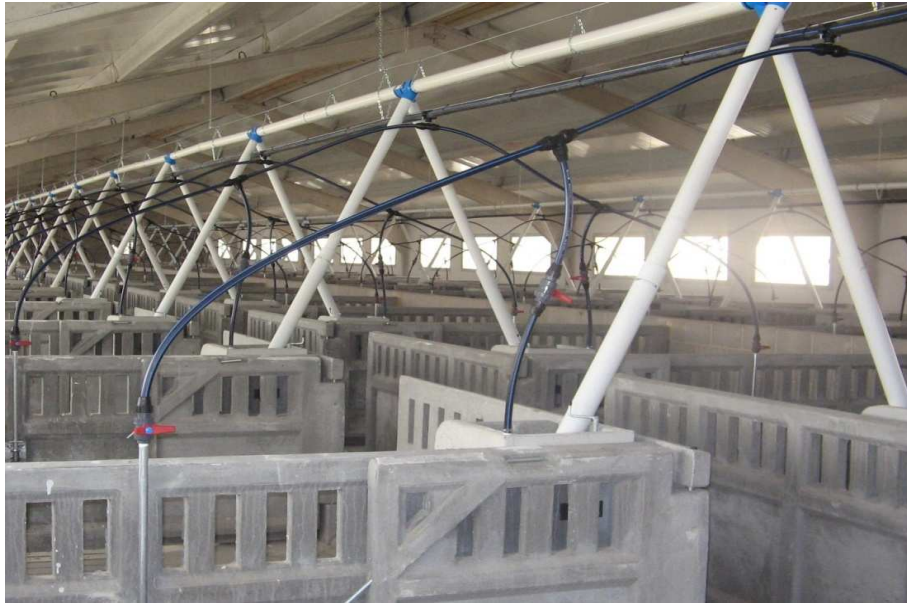
Imagen 9. Nave real con el sistema de alimentación y bebederos comentados.
