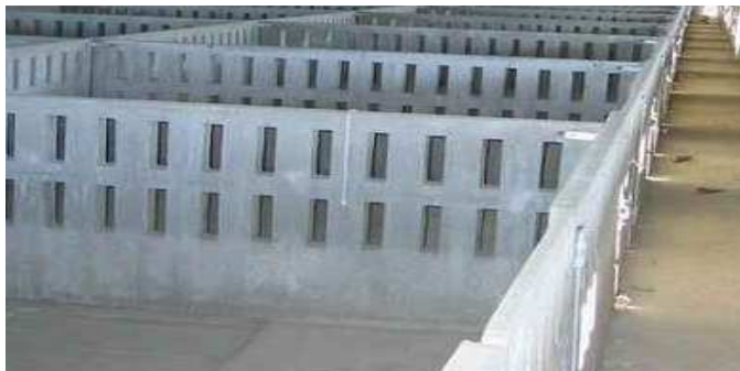
Imagen 2. Ejemplo de recinto construido mediante separadores prefabricados de hormigón.
