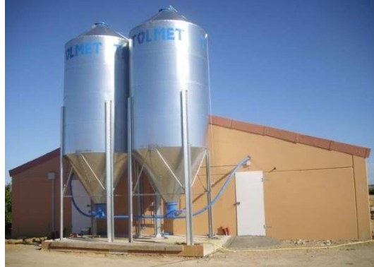
Imagen 25. Silos de chapa de acero lisa.
