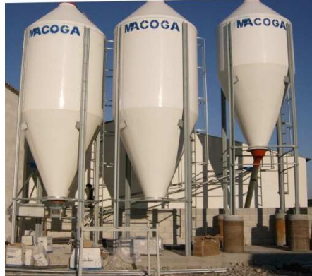
Imagen 23. Silos de PVC reforzados con fibra de vidrio.
