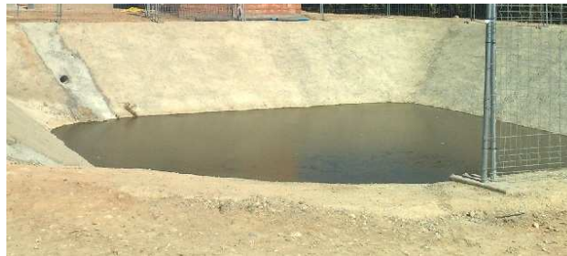
Imagen 30. Balsa de almacenamiento de purín y vallado perimetral.
