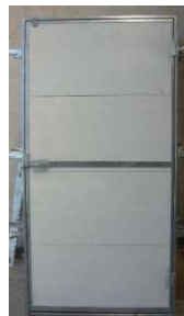
Imagen 10. Puerta de acceso a salas de cebo.
