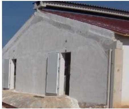
Imagen 16. Caso real con sistema de ventilación natural con caballete abierto en la cumbre.
