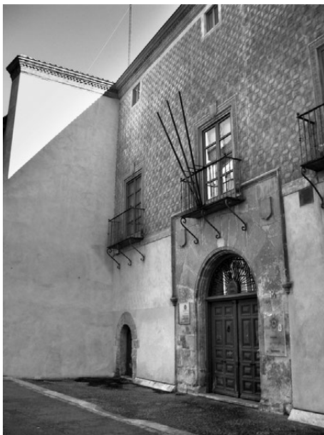
13. Casa del conde de Buendía. Fachada. 14. Casa del conde de Buendía. Sección en el estado previo a intervención.
