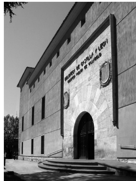
1. Palacio de los condes de Benavente. Fachada principal.
