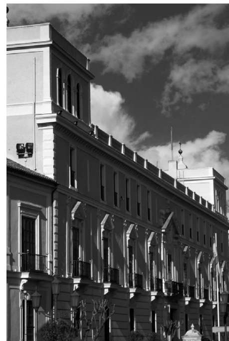
11. Palacio Real. Fachada principal.
