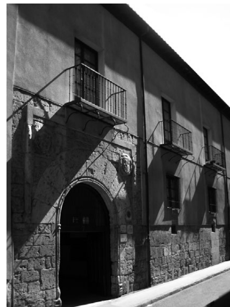
1. Casa del licenciado Francisco Fresno de Galdo. Fachada estado actual.
