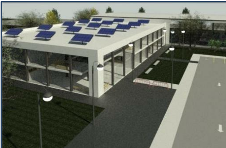
Figura 2. Acceso peatonal Fuente: Elaboración propia
