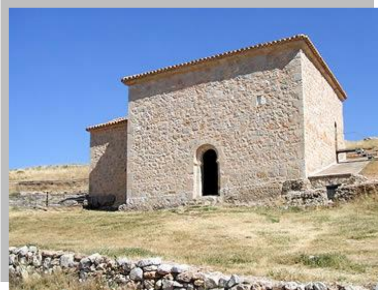
Fachada principal de la ermita.
