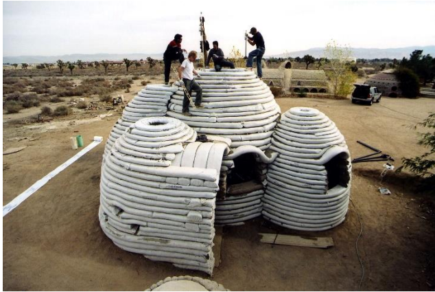
Fotografía 46. Refugio progresivo de superadobe. Fase deconstrucción. Fuente: https://www.akdh.org/architecture/project/sandbag-shelters
