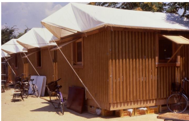
Fotografía 40. Refugio transitorio de cartón. Prototipo construido en Kobe (Japón). Fuente: MIYAKE, Riichi, LUNA, Ian, A, GOULD, Lauren. Shigeru Ban: Paper in Architecture / essays . Rizzoli International Publications, 2009.
