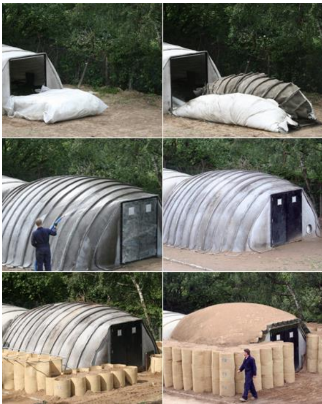
Fotografía 01. Instalación del refugio Concrete Canvas. Fuente: https://www.concretecanvas.com/cc-shelters
