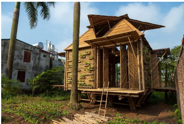
Fotografía 37. Refugio transitorio de bambú. Prototipo construido. Fuente: https://www.plataformaarquitectura.cl/cl/02-297672/casa-bb-h-and-p-architects
