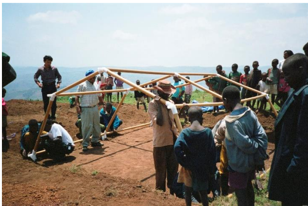
Fotografía 31. Refugio de emergencia. Proceso de instalación por la comunidad. Imagen© Shigeru Ban Architects.
