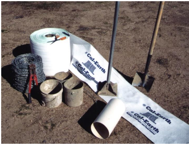
Fotografía 47. Refugio progresivo de superadobe. Únicos materiales necesarios. Fuente: https://www.calearth.org/intro-superadobe
