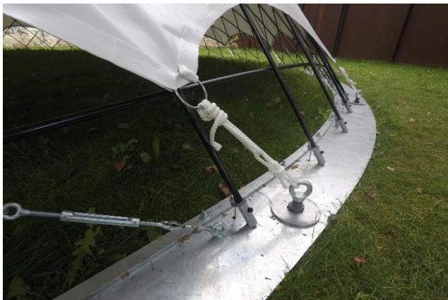
Fotografía 08. Refugio de emergencia Sheltair. Sistema de anclaje. Fuente: https://www.plataformaarquitectura.cl/cl/884525/membrana-reticular-economica-y-facil-de-usar-utiliza-cojines-rellenos-de-aire-para-la-construccion
