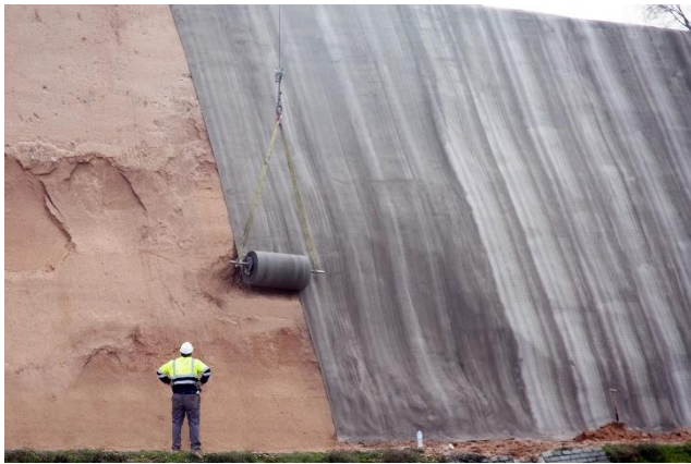
Fotografía 11. Aplicación civil de CC Revestimiento en diques de contención. Fuente: https://www.flickr.com/photos/_concretecanvas/sets/72157638403394195/
