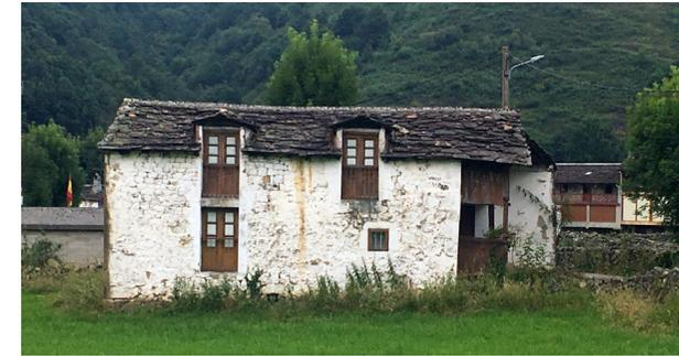
Figura 75. Casa con ampliación para baño y apertura de huecos en fachada.
