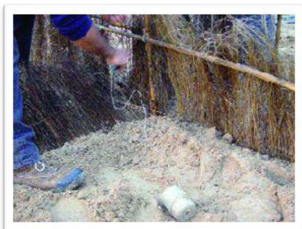
Ilustración 3. Realización de captadores de espartina. Fuente: Manual de restauración de dunas costeras, Ministerio de Medio Ambiente.
