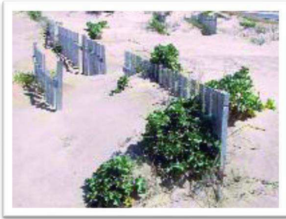
Ilustración 1. Tablaestacas de madera. Fuente: Manual de restauración de dunas costeras, Ministerio de Medio Ambiente.
