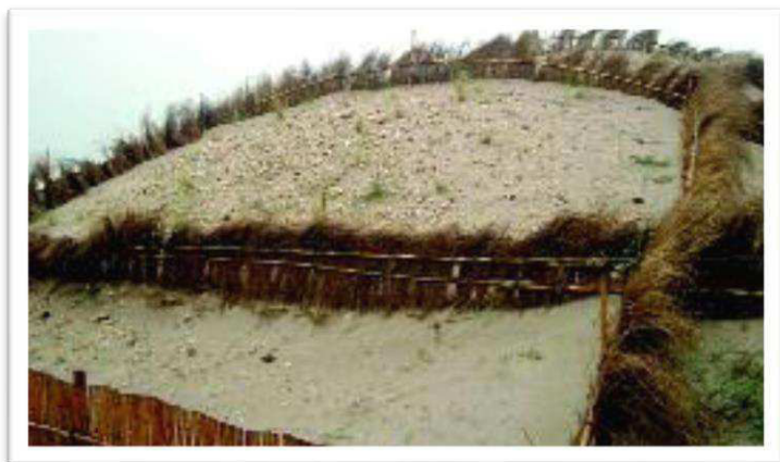
Ilustración 2. Captadores de espartina. Fuente: Manual de restauración de dunas costeras, Ministerio de Medio Ambiente.
