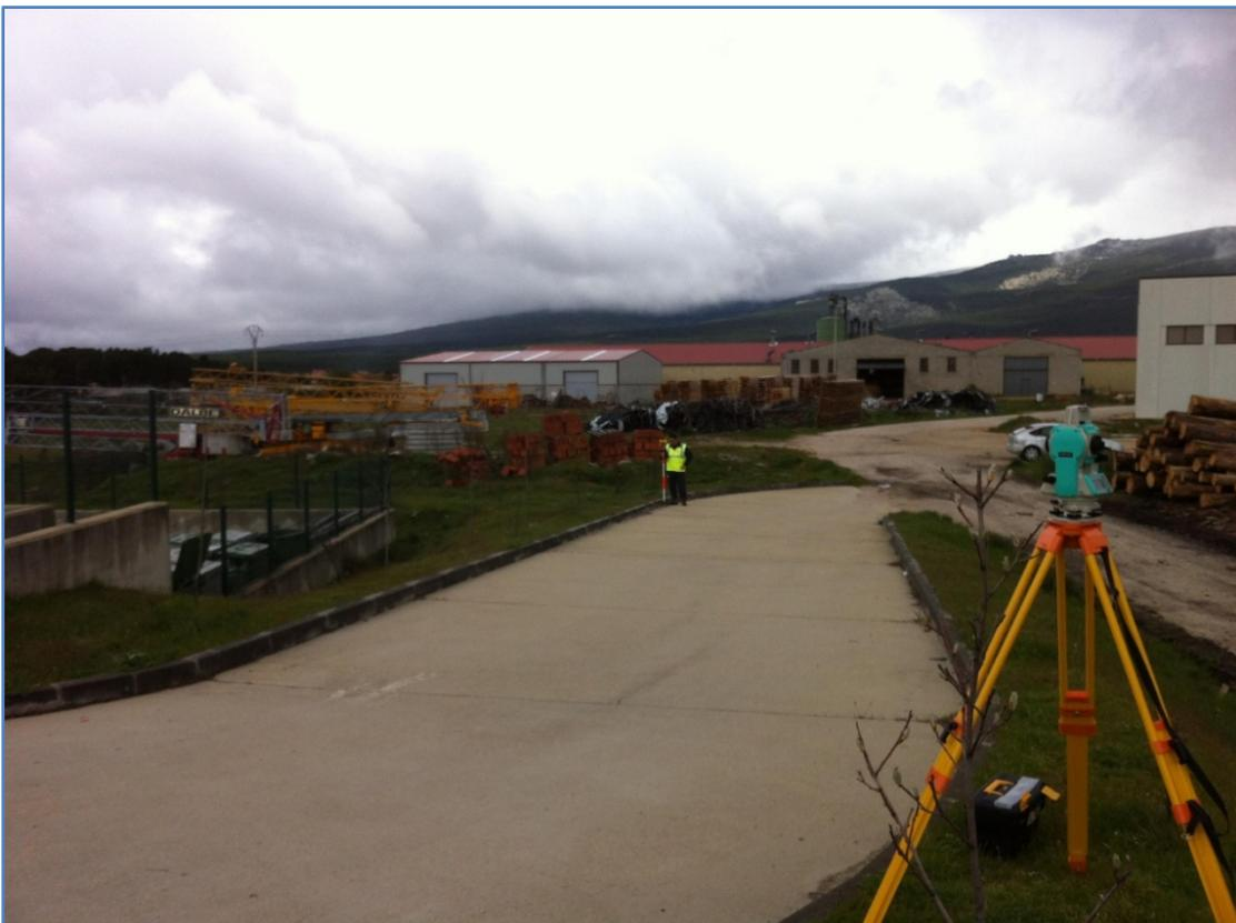
Levantamiento topográfico. Vial acceso Punto Limpio.
