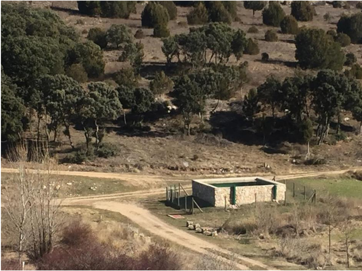
Figura 76. Punto de agua de gran capacidad (90.000 litros) como el que se proyecta. Fuente: Servicio Territorial de Medio Ambiente de Palencia.
