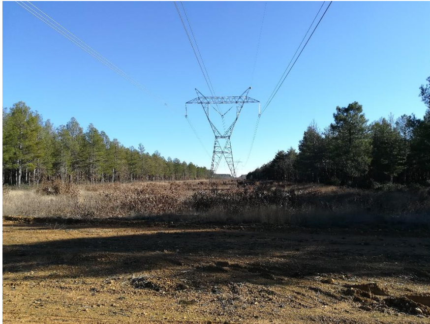
Ilustración 42. Cortafuegos del tendido eléctrico de 400 kV de HERRERA-VILECHA que atraviesa el M.U.P 32 Bostal y Albarizas. Fuente: Elaboración propia.
