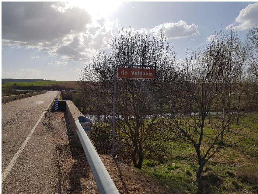
Ilustración 22. Puente sobre Rio Valdavia por su paso por el término municipal de Villaeles de Valdavia, por la carretera P-230. Elaboración propia.
