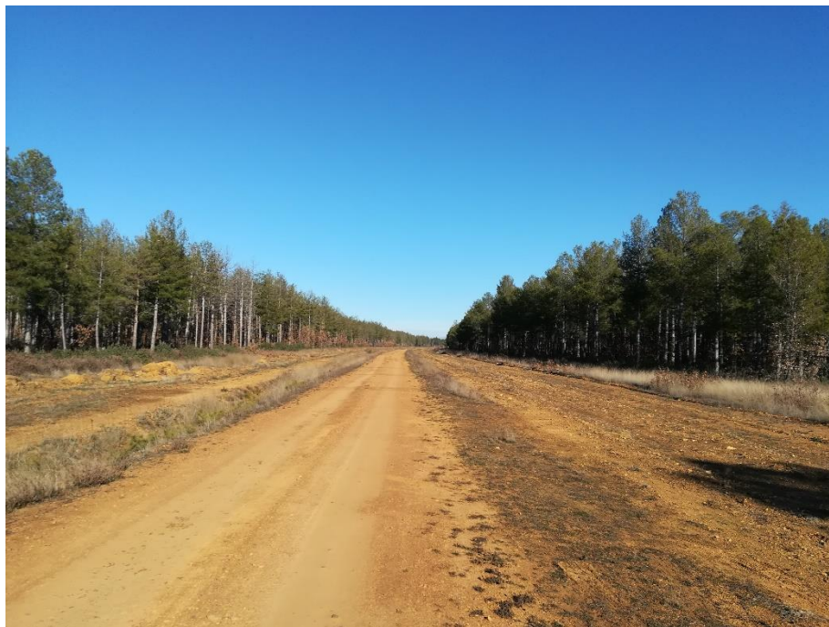
Ilustración 43. Cortafuegos y camino en el M.U.P 322 Bostal y Albarizas. Fuente: Elaboración propia
