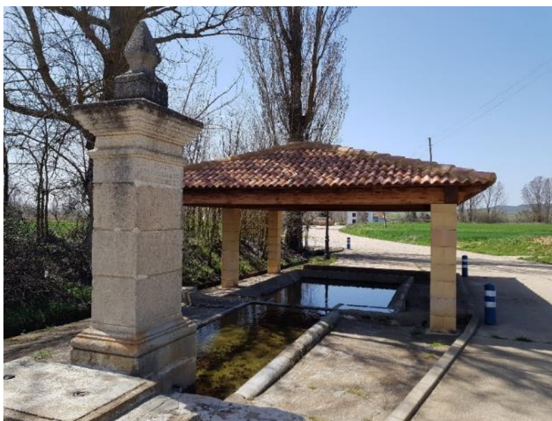
Figura 22. Lavadero municipal restaurado en el municipio de Villanuño de Valdavia. Elaboración propia.
