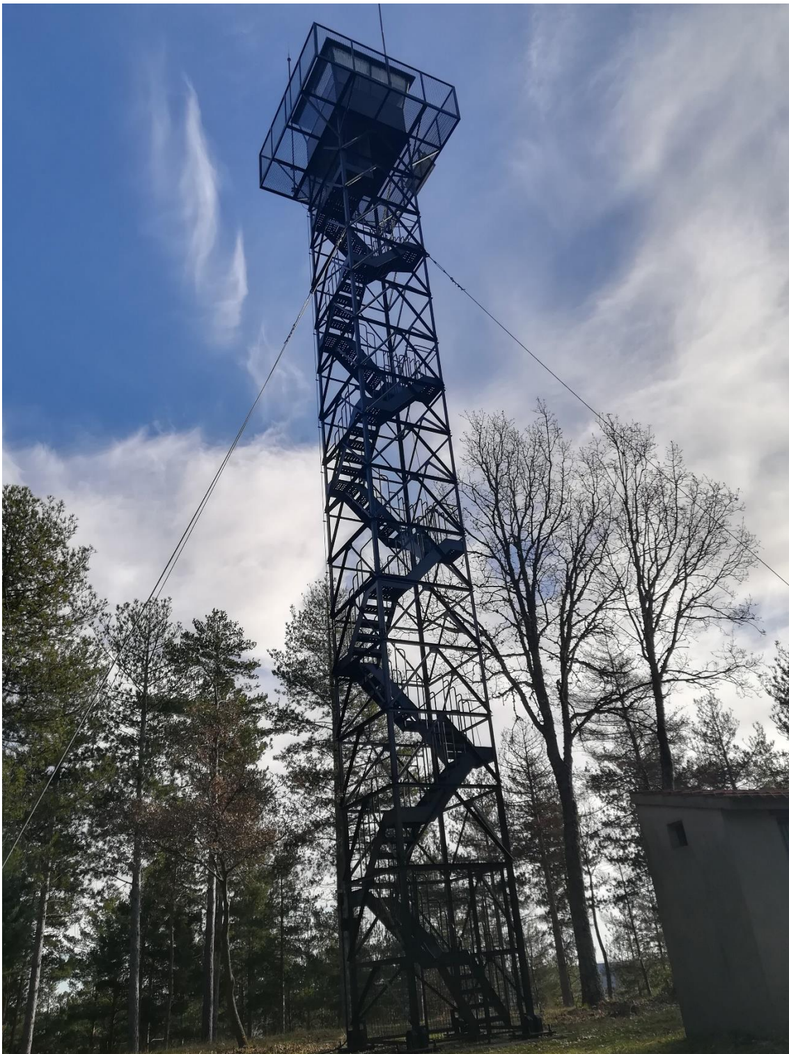
Ilustración 39. Torre de vigilancia de Rodiles. Fuente: Elaboración propia.
