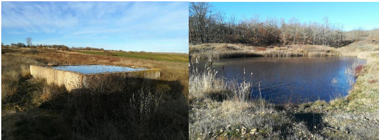
Figura 26. A la derecha depósito de hormigón de Rabanillos a la izquierda presa San Martin del Monte ambos puntos de agua de la zona norte de la comarca. Fuente: Elaboración propia.
