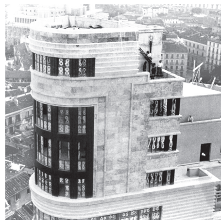
35 Torreón en construcción.
