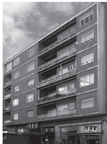
1 Julio Cano Lasso, Edificio de viviendas y cine . Soria (1956-1960). Fachada en avenida de Navarra [Foto 2005: Antonio Álvaro Tordesillas]
