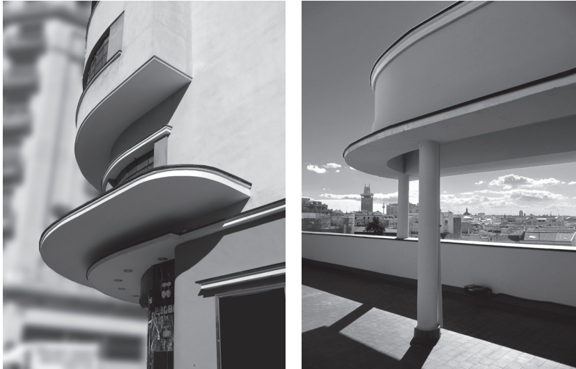
12 Luis Gutiérrez Soto, Cine Barceló . Madrid (1930-31). Marquesina esquina calles Barceló y Larra y marquesina en sala de proyección de cubierta [Fotos 2010: Daniel Villalobos Alonso]
