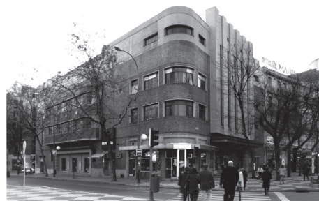
6 Luis Labat Calvo, Universal Cinema . Madrid (1946-53). Vista del edificio antes de su reconversión, 2000 [Servicio Histórico COAM]
