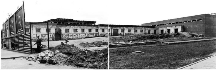
Instituto Núñez de Arce. Apertura de la calle Jorge Guillén.
