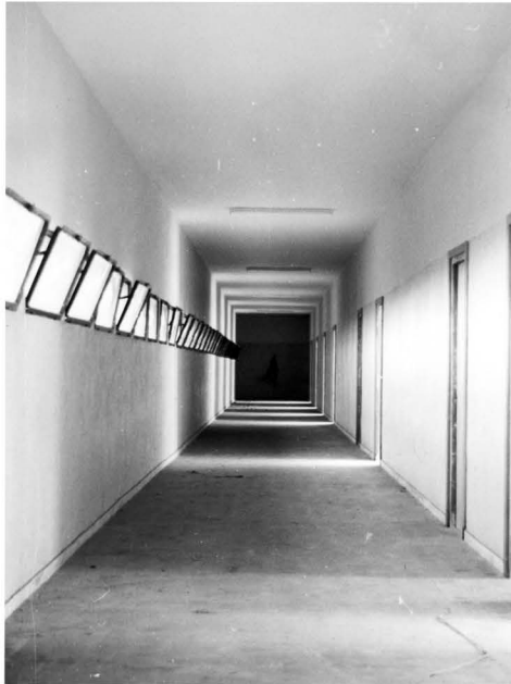
Instituto Núñez de Arce en construcción. Galería Este-Oeste de acceso a aulas.
