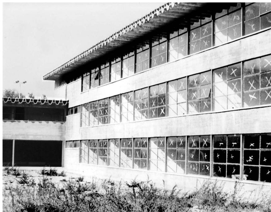
Instituto Núñez de Arce en construcción. Bloque de aulas.
