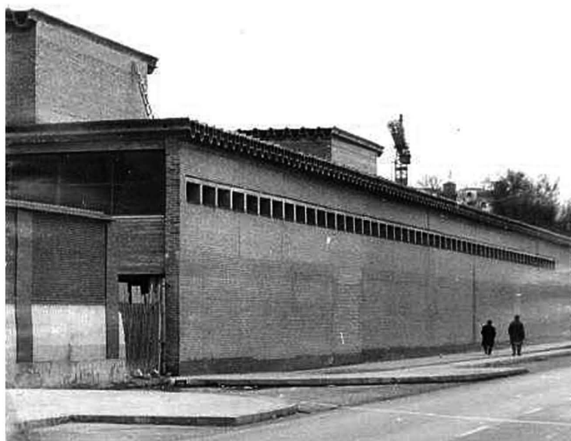
Instituto Núñez de Arce en construcción. Fachada al Paseo Isabel la Católica.
