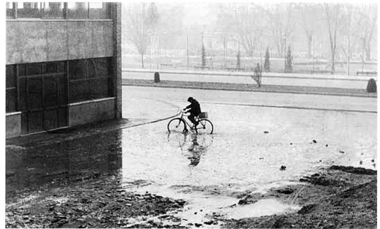
Instituto Núñez de Arce. Apertura de la calle de la Encarnación.
