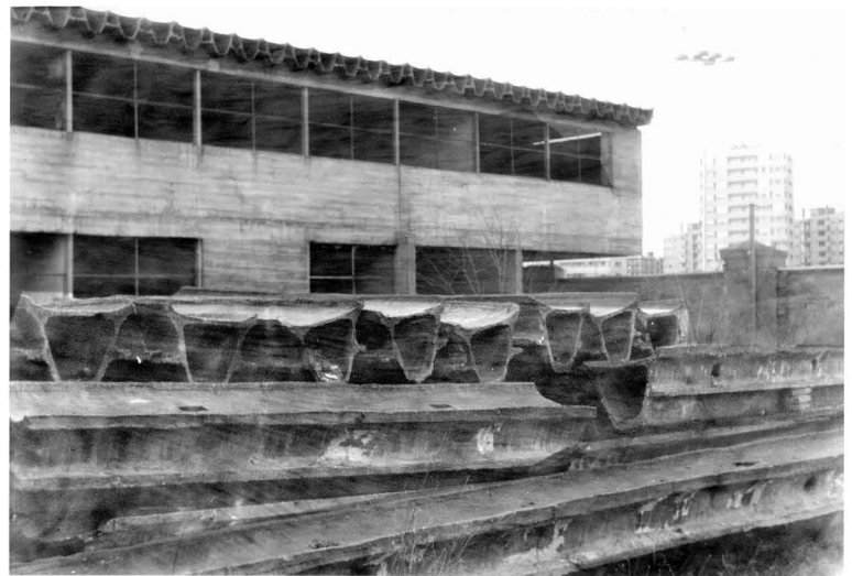
Instituto Núñez de Arce en construcción. Bloque Sur.
