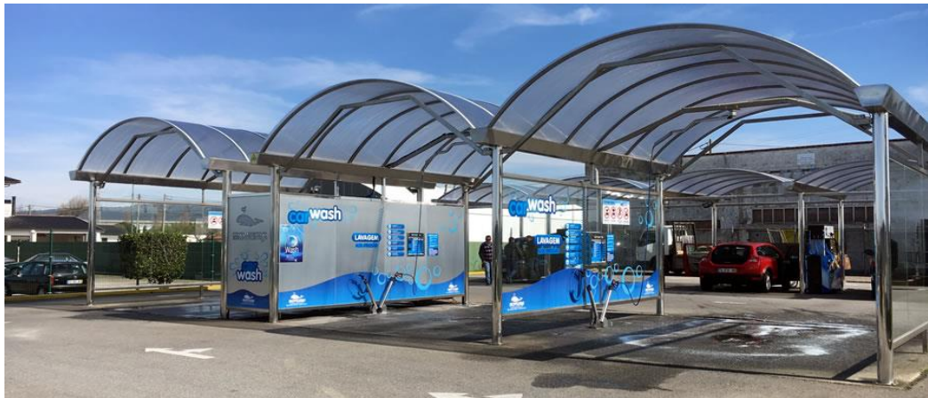
Imagen 20: Pista de lavado
