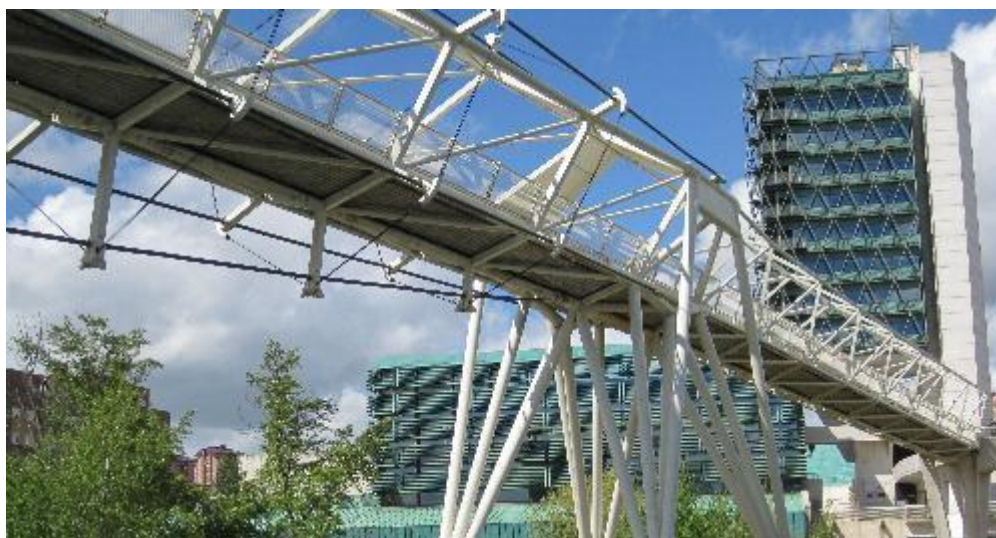
Figura 1.1 Pasarela del Museo de la Ciencia sobre el río Pisuerga, Valladolid. Imagen de www.Valladolidweb.es
