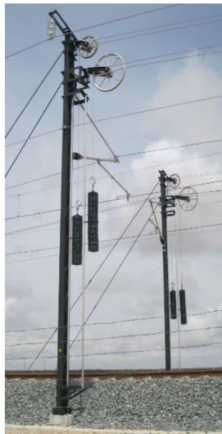
Figura: 3.34: Equipo de compensación mediante contrapesos
