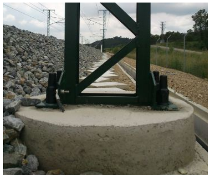
Figura 3.18: Cimentación cilíndrica
