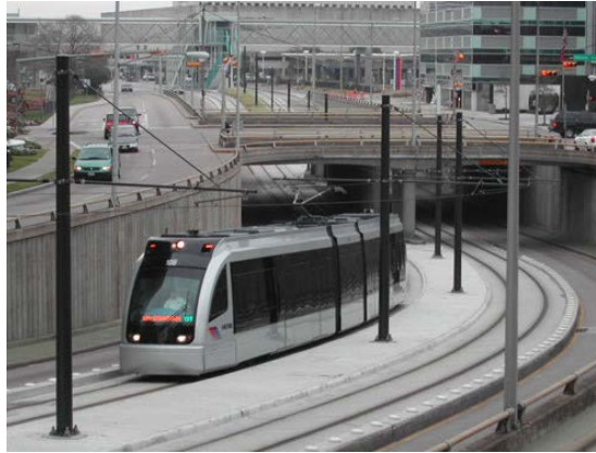
Figura 3.6: Paso a distinto nivel
