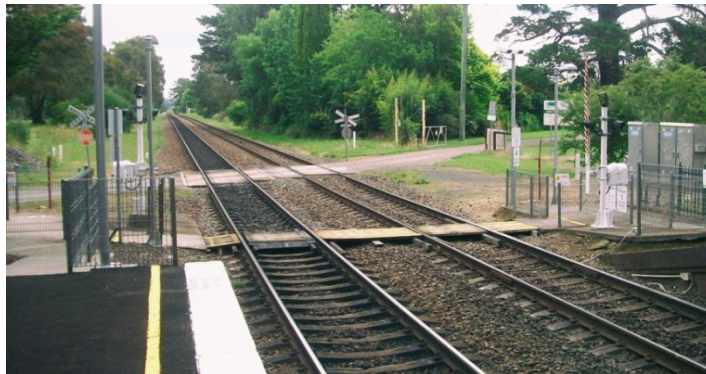
Figura 3.7: Paso a nivel
