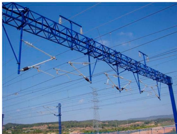
Figura 3.23: Ejemplo de pórtico para varias vías
