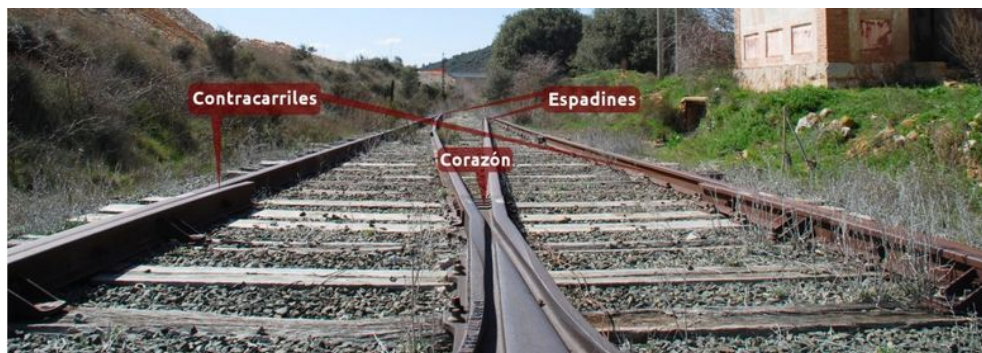
Figura 3.11: Elementos que componen los cambios de agujas
