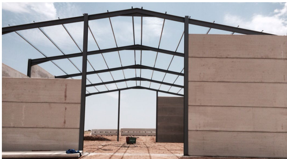
Figura 1 Perfil HEB con hormigón prefabricado. Fuente: www.placasalveolares.com
