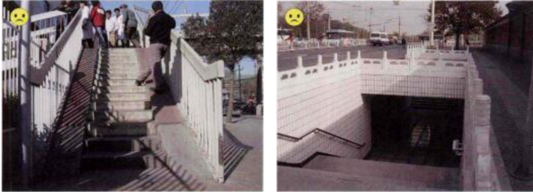
Figura 28: Paso elevado de Calle de Zi Zhu Yuan (La foto de la izquierda) 紫竹院过街天桥 Pasaje subterráneo de Avenida Chang An (La foto de la derecha) 长安大街地下通道
