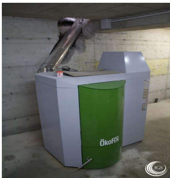
Figura E.4: Silo integrado. Fuente: Ökofen.
