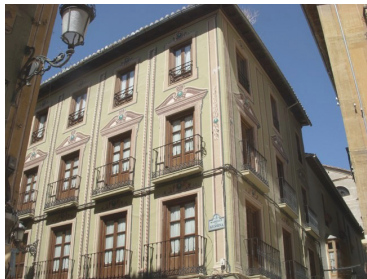
Fig. 37: Palacio de la Madraza, Granada, ventanas y detalles en los cercos con trampantojos.
