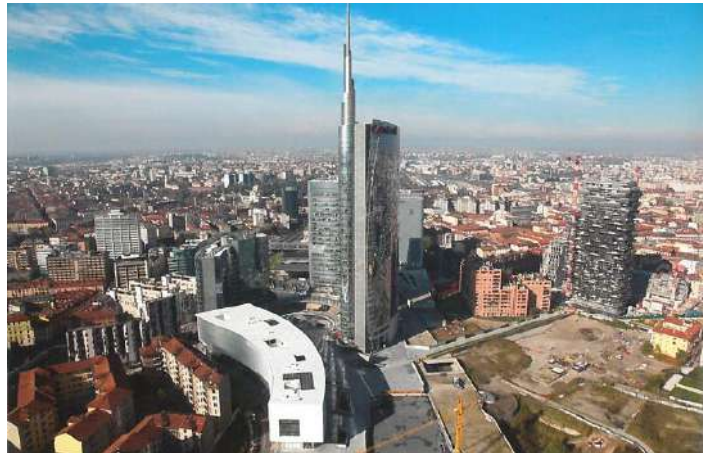
Ilustración 61. Vista aérea estado actual Isola. Fuente: Edifici per uffici UniCredit Headquarters - P.I.I. Garibaldi Repubblica - milano che cambia - Ordine degli architetti, P.P.C della provincia di Milano. (2019). Consultado en Junio 2019, from http://www.ordinearchitetti.mi.it/it/mappe/milanohecambia/edificio/289-edifici-per-uffici-unicredit-headquarters/46-p-i-i-garibaldi-repubblica
