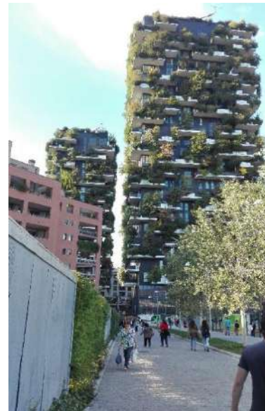
Ilustración 66. Fotografía del Bosco Vertical. Fuente: Elaboración propia.
