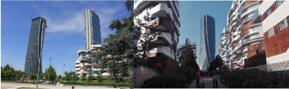
Ilustración 56 y 57. Torres y edificios residenciales vistos desde Piazzale Giulio Cesare (izquierda). Fuente: fotografías tomadas por De las Rivas J. Calle peatonal de acceso al bloque de edificios residenciales diseñados por Zaha Hadid con la torre de Zaha Hadid de fondo (derecha) Fuente: elaboración propia.
