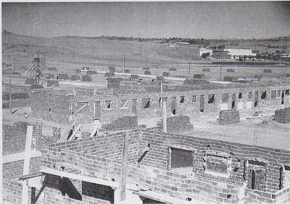
7. El barrio en construcción.
