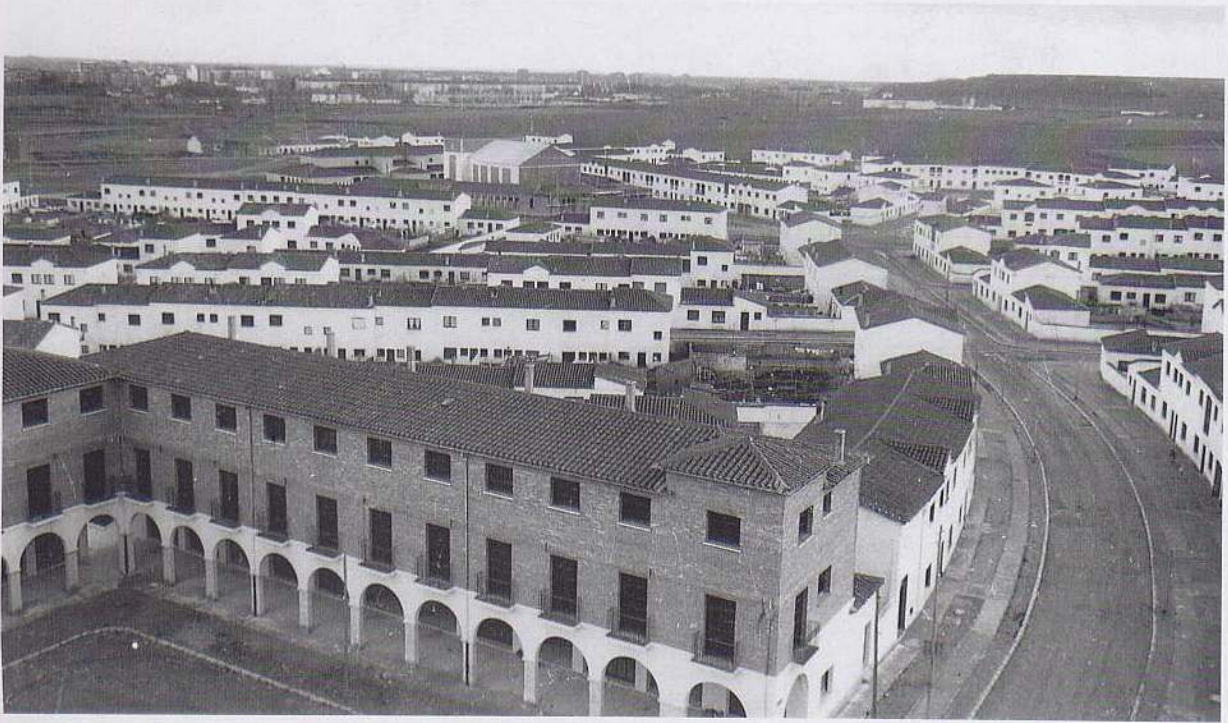
1. El barrio en construcción.
