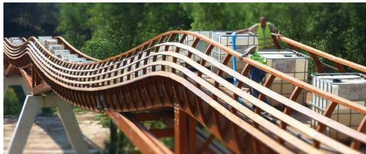
Figura 1.2: Puente de Pesquera de Duero
