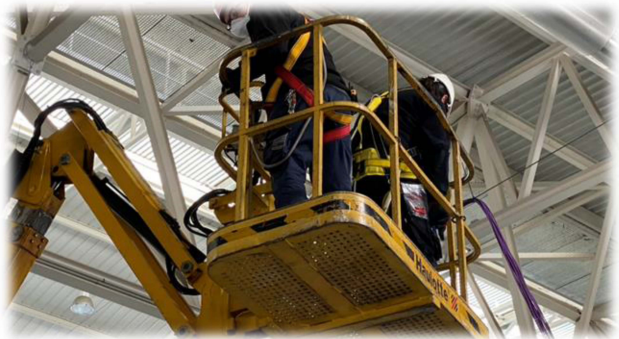
Descontaminación de techos
