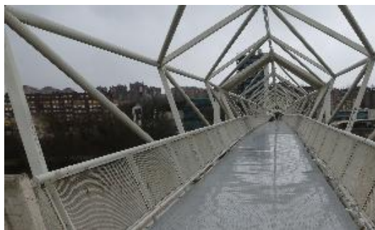
Imagen 1. Pasarela peatonal del Museo de la Ciencia, Valladolid [2]
