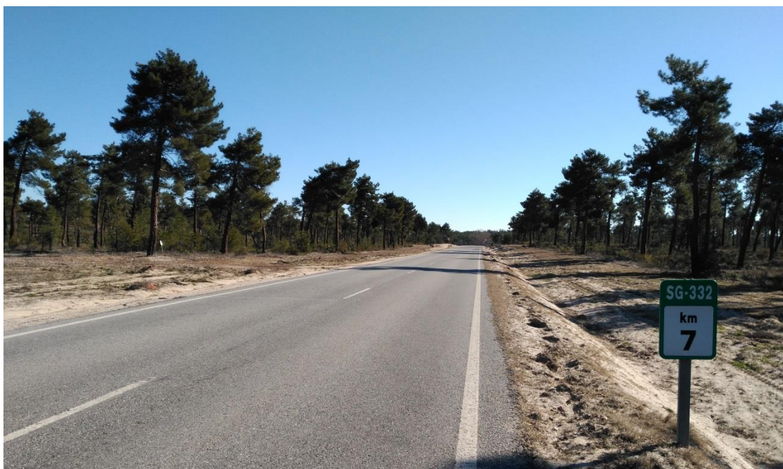
Foto nº 20: Carretera SG-332, que atraviesa los rodales 1, 2 y 4. (Fuente: Elaboración propia).
