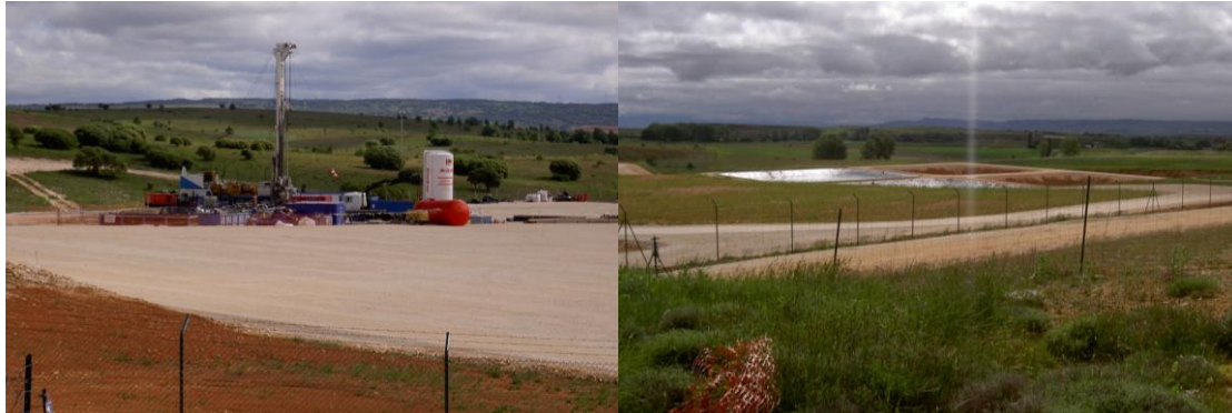
FIG. 20.5. Estado actual del proyecto de la Planta de Desarrollo Tecnológico para almacenamiento de CO 2 en Hontomín (Merindad de Río Ubierna). Obra civil, ejecutada sobre una plataforma de 25.000 m 2 , e inicio de la perforación de los pozos. En la imagen de la derecha, balsas de almacenamiento de agua.
