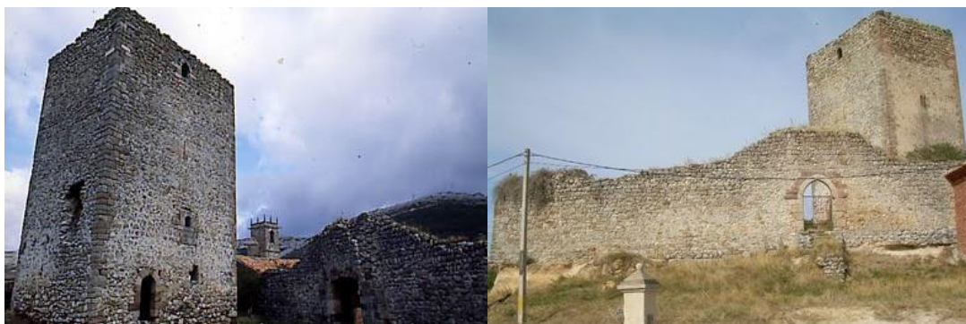
FIG. 23.14. Castillo de Rebolledo de la Torre.
