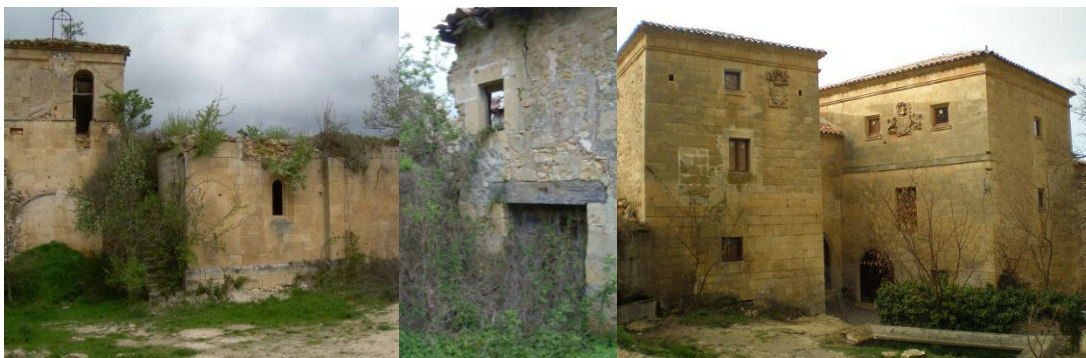
FIG. 23.32. Cortiguera. Ruinas de la iglesia y parte del caserío y Casonas.
