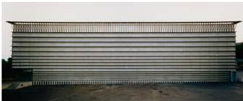
fig. 73 – Armazém Ricola, 1987, de Herzog & de Meuron
