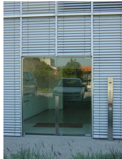
fig. 94 – Pormenor da entrada do Prédio da Maia
