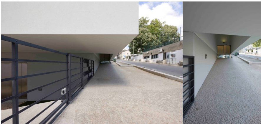
fig. 267 – Acesso ao interior do corpo novo do Museu de Arte Contemporânea de Bragança
