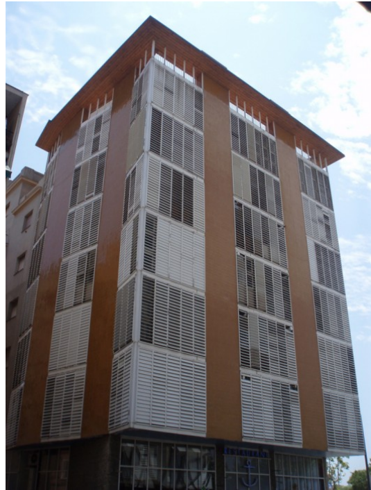
fig. 89 - Edifício La Barceloneta (1951) - Coderch
