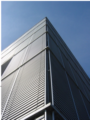
fig. 93 – Pormenor do canto da fachada do Prédio da Maia
