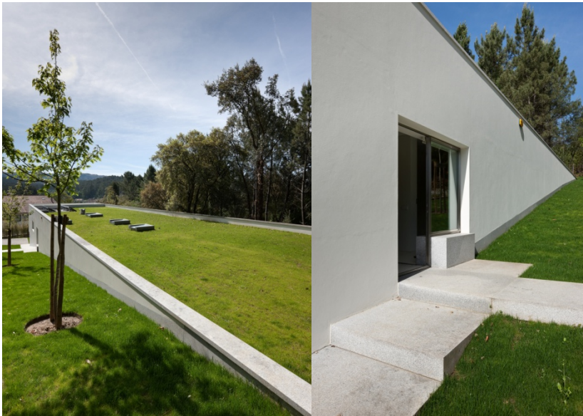
fig. 281 – Imagem da cobertura ajardinada e da porta de entrada da Casa D6-III
