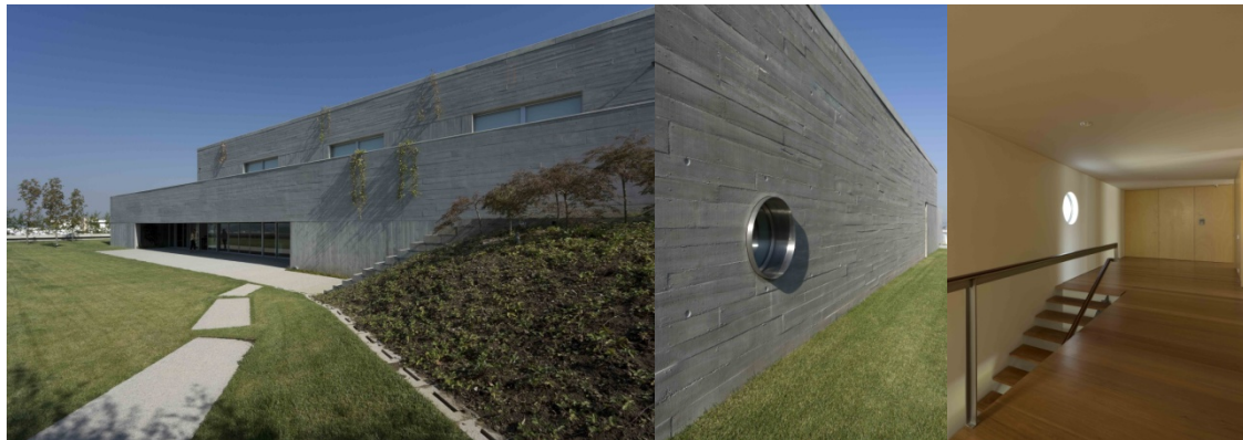
fig. 292 – À esquerda aberturas nos muros de betão e á direita o “oculo” visto por fora e por dentro na Casa do Bom Jesus 2
