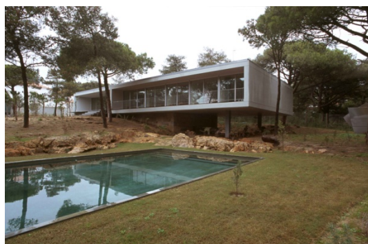
fig. 188 – Piscina da Casa de Cascais
