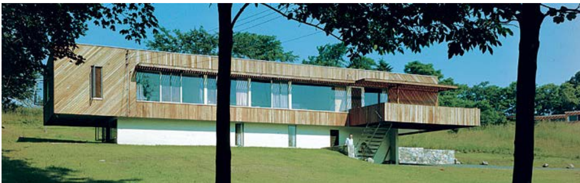
fig. 328 – Casa Breuer I, Marcel Breuer
