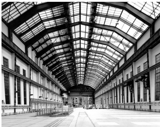
fig. 37 – Interior da fabrica AEG - Peter Behrens
