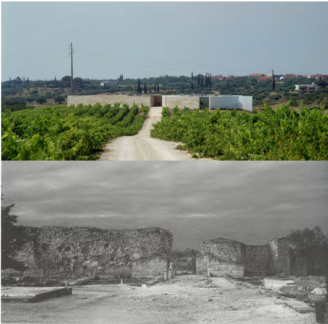
fig. 57 – Casa de Alcanena na parte superior e ruína da Villae Romana no inferior
