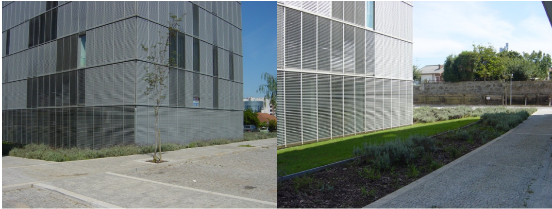
fig. 92 – Integração do Prédio da Maia com o terreno envolvente
