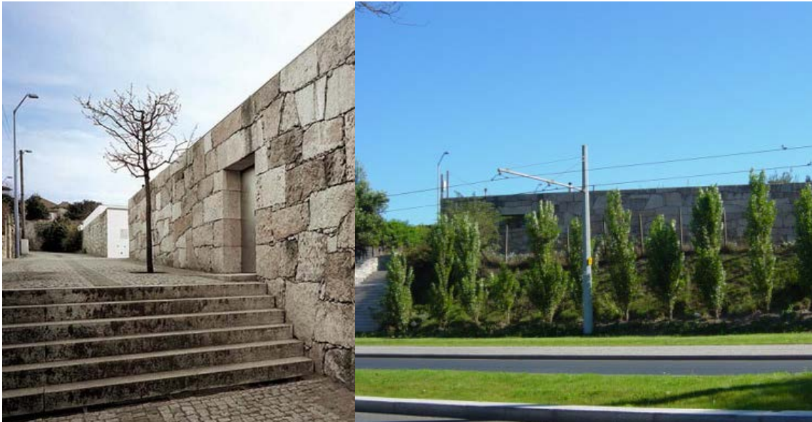
fig. 25 – Porta de acesso e janelas para a rua - Casa de Matosinhos
