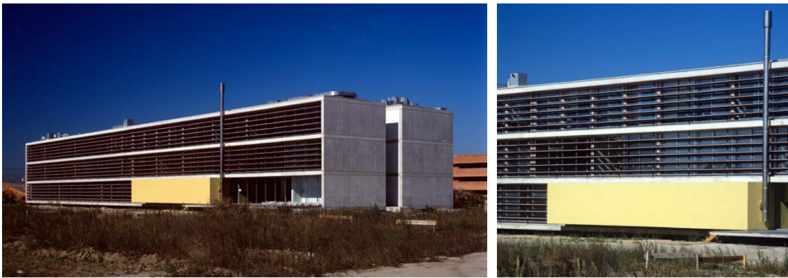
fig. 374 – Imagens do Departamento de Geociências de Aveiro com a sua chaminé
