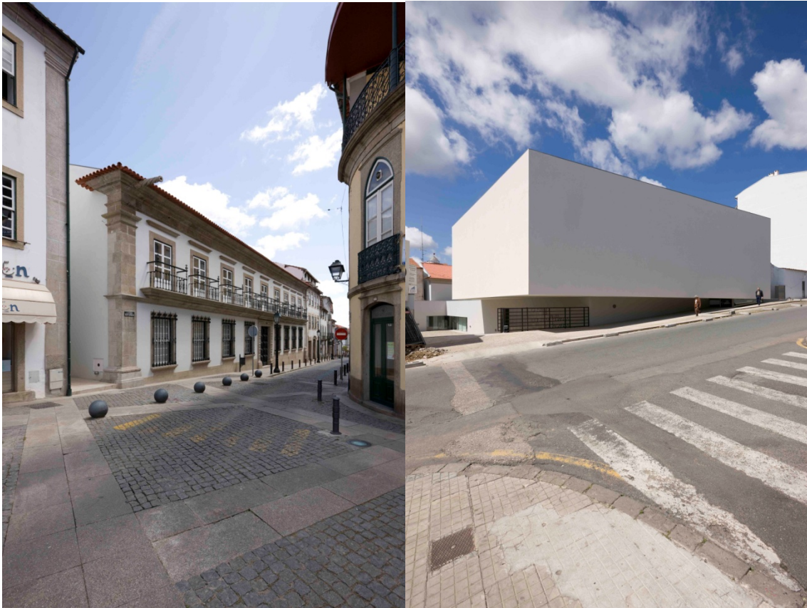
fig. 264 – Imagens do Museu de Arte Contemporânea de Bragança, alçado Sul e alçado Norte
