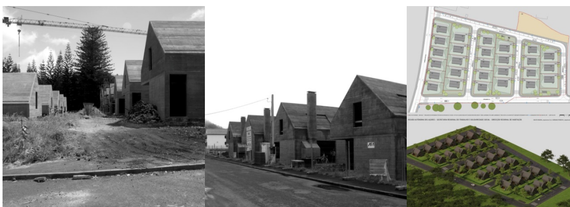
fig. 338 – Imagens dos arruamentos do Loteamento das Setes Cidades
