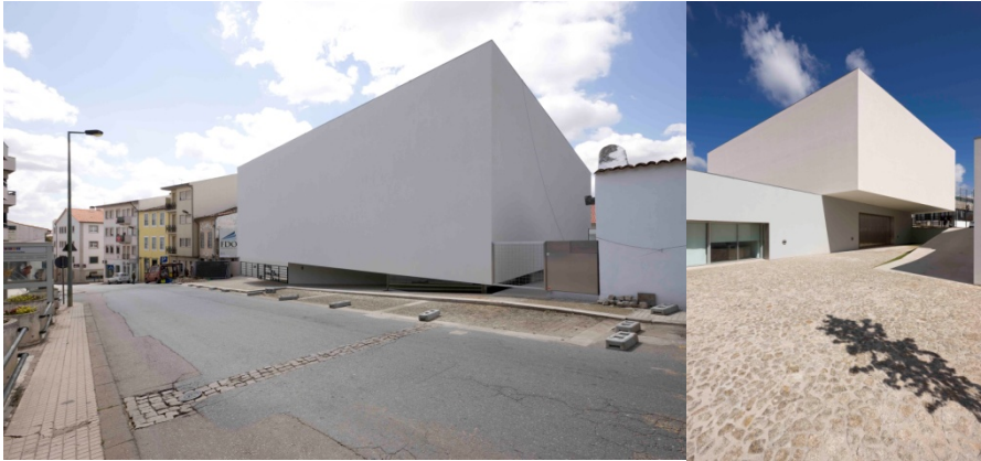
fig. 266 – Relação do novo volume do Museu de Arte Contemporânea de Bragança com o arruamento a Norte, a maneira como “pousa” no volume que faz a ligação entre ruas
