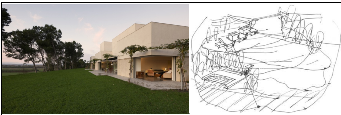
fig. 294 – Imagem do terreno onde está implantada a Casa de Llàbia e esquiço de ESM da implantação
