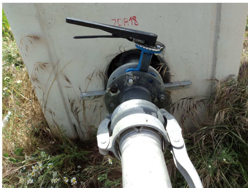
Figura 5: Montaje de la válvula de mariposa y rótula con brida a la toma de la parcela mediante tornillos
