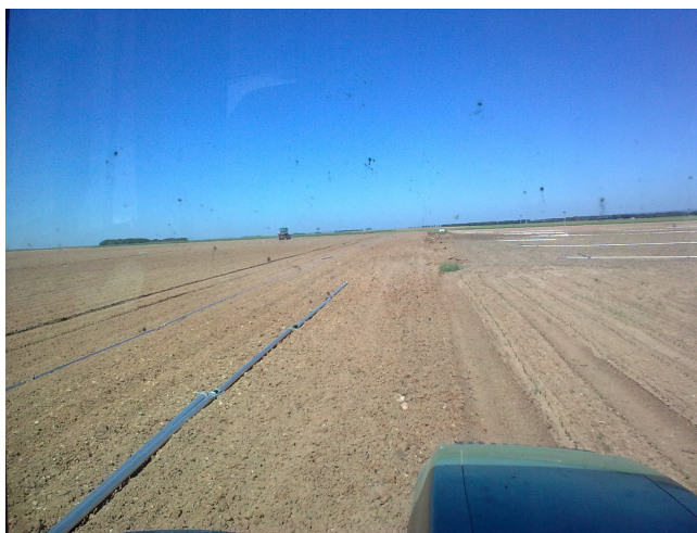
Figura 2: Colocación de la red de riego
