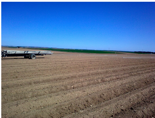
Figura 6: Montaje de la red de riego con un carro de tubos
