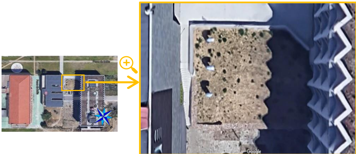
Figura 3. Vista aérea aumentada de la entrada del intercambiador del edificio LUCIA [37].
