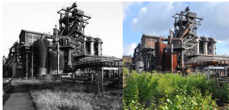
Fig. 3.14. – 3.15. – 3.16. – 3.17. En las dos imágenes de la parte superior se observa la transformación funcional de la antigua central eléctrica en un espacio multifuncional.
