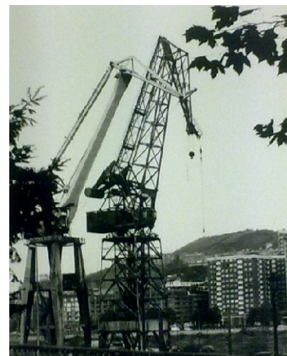
Fig. 3.24. La crisis de la industria provocó el abandono y la posterior desaparición de las huellas industriales. En la imagen, la grúa La Carola, único vestigio industrial conservado en el denominado Paseo de la Memoria.
