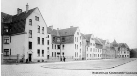
Fig.1.5. Construcción del nuevo barrio obrero cerca de la Planta Metalúrgica de Duisburg, en el año 1906-1912.
