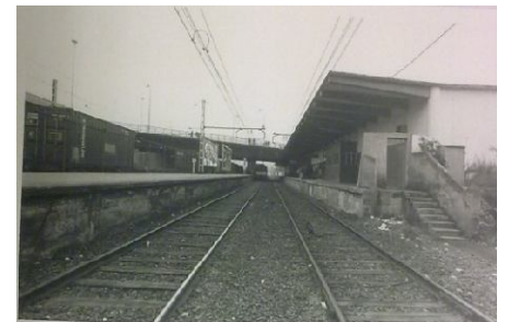
Fig. 1.3 – 1.4. Estación de trenes, construida en Abandoibarra, Bilbao.
