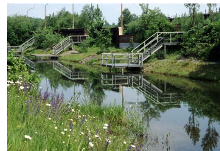
Fig. 3.13. El antiguo canal de aguas negras discurre por una canalización subterránea, bajo el nuevo canal del río Emscher.
