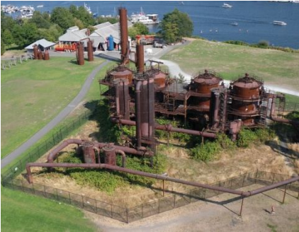
Fig. 4.16. Vista aérea del parque Gas Works. Únicamente la zona que se observa al fondo de la imagen puede ser utilizada.
