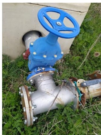
Ilustración 1: Toma de agua para el sistema de riego.
