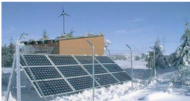
Instalación eólico-fotovoltaica aislada
