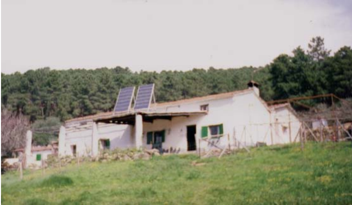
Módulos solares fotovoltaicos
