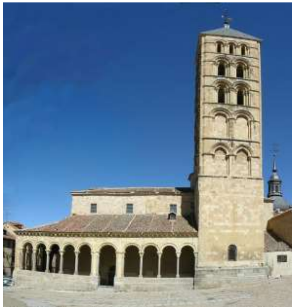
Vista de la torre de la iglesia de San Esteban y su atrio
