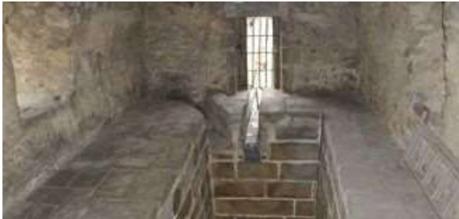
Interior del desarenador
