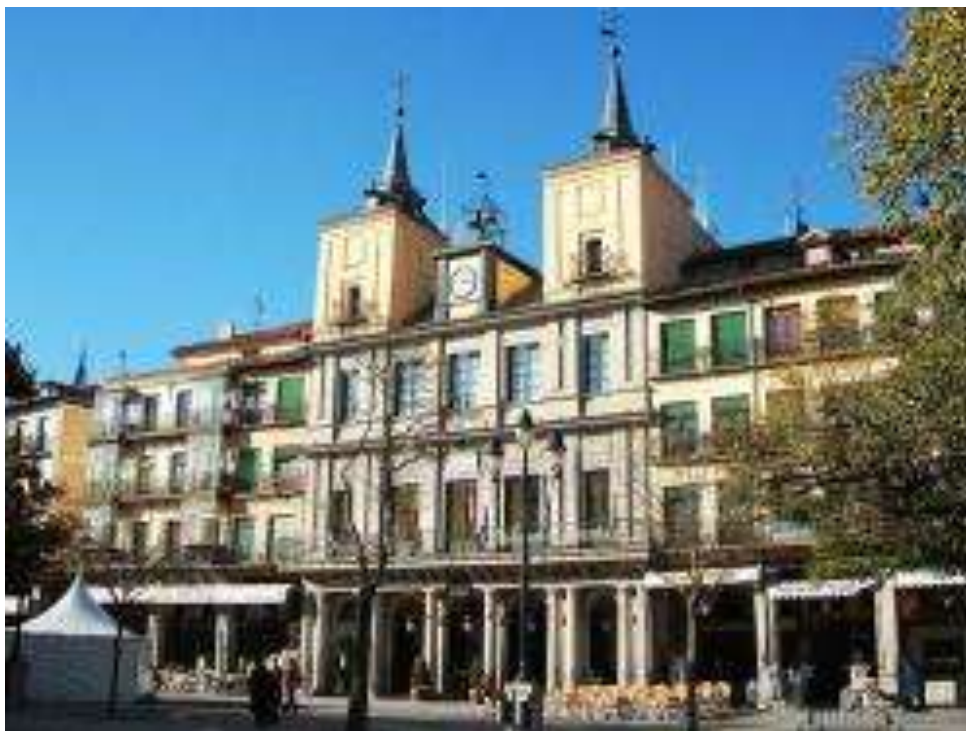
Fachada principal del Ayuntamiento
