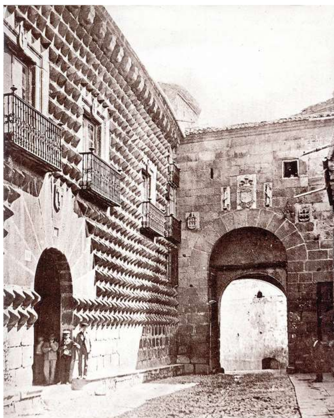
Fig. 20: La Puerta de San Martín antes de su demolición en 1883
