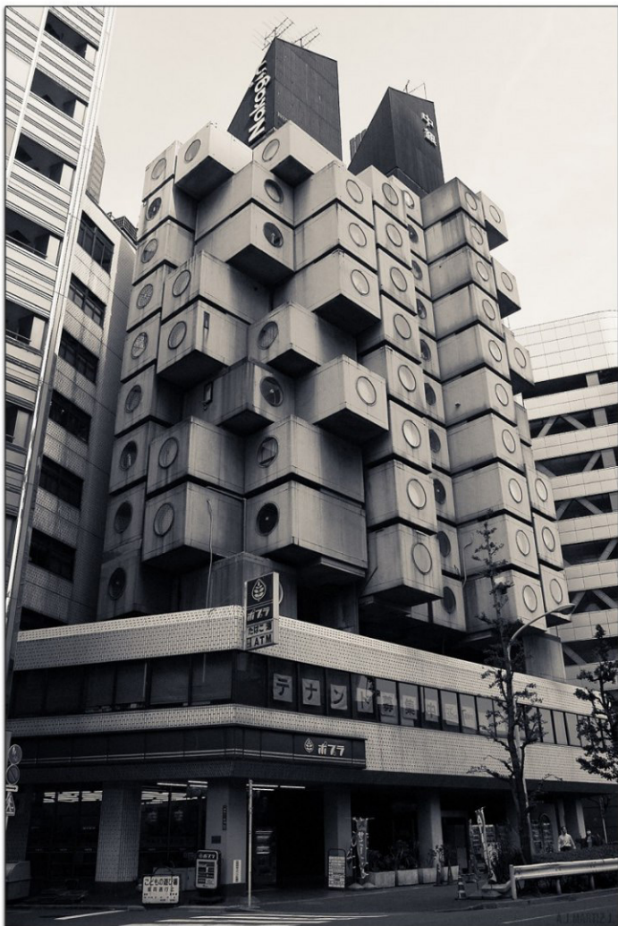
188. La torre Nagakin de Kisho Kurokawa con sus viviendas modulares obre el mastil de las comunicaciones
