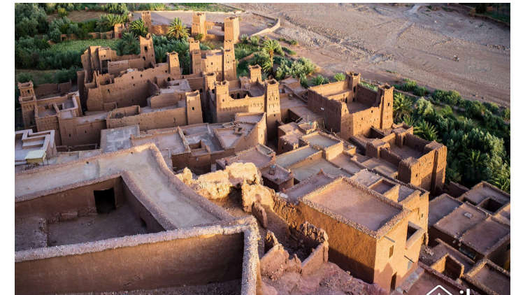
322. Fotografía de las ruinas de la ciudad marroquí de Ait Ben Haddou en la que se aprecian las cubiertas planas de las viviendas
