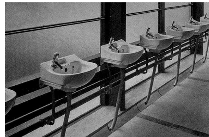
99. Fotografía de los baños de la escuela de Norwich de los Smithson
