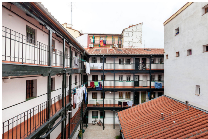
305. Fotografía de una de las corralas que todavía se conservan en el madrileño barrio de Lavapiés
