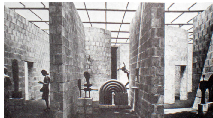
281. Fotografía del pabellón original en 1966
