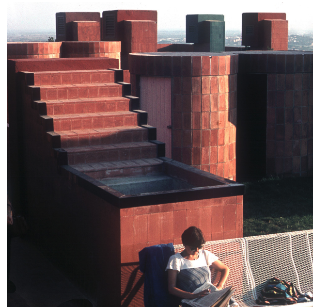
335. Fotografía donde se aprecian los distintos elementos de la cubierta del Walden 7
