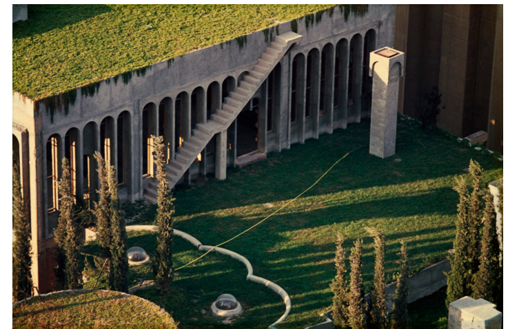
104. Fotografía de la escalera en la cubierta jardín de La Fábrica
