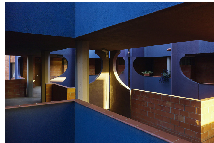
260. Fotografía de los recorridos peatonales internos del Barrio Gaudí en Reus, de Taller de Arquitectura
