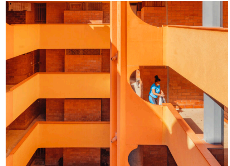
3. Fotografía de uno de los patios del Barrio Gaudí en Reus
