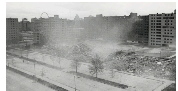
360. Secuencia de la demolición de Pruitt-Iggoe el 15 de Julio de 1972
