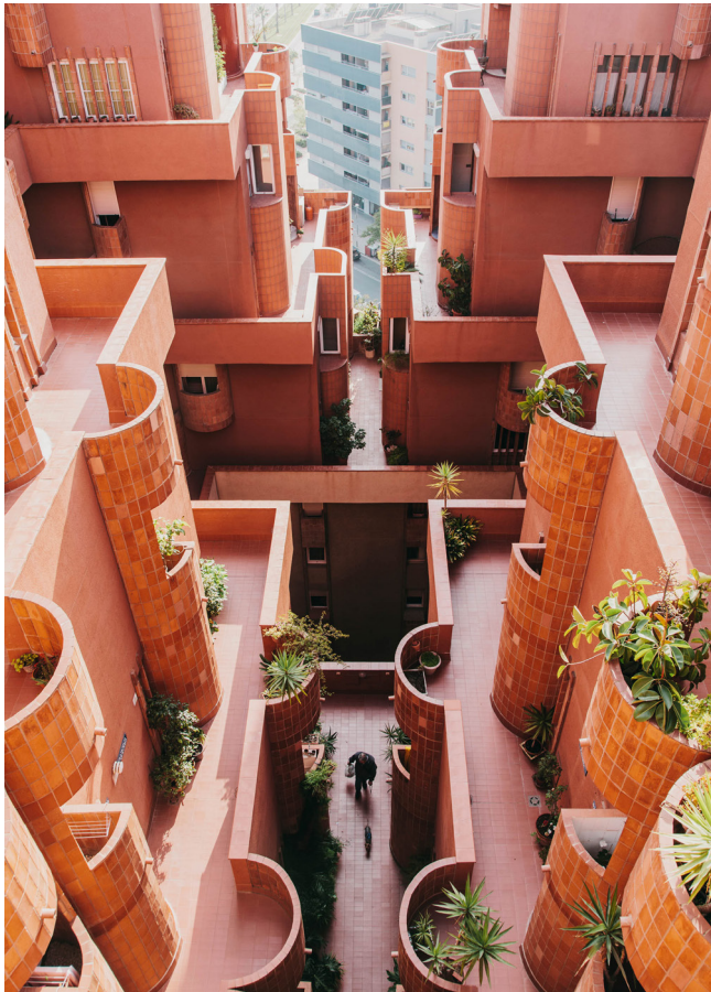
282. Fotografía en la que se observan las dilataciones y contracciones en la calle del Walden 7 cerca de los accesos de las viviendas
