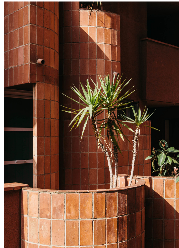
301. Balcones y salientes de las casas del Walden 7 decorados con rajolas de terracota de 16x32,5 cm colocadas a junta corrida
