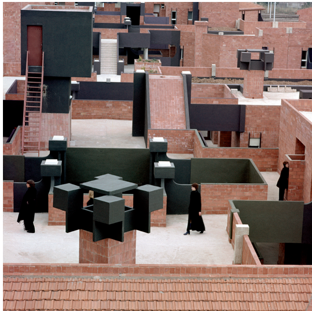
333. Fotomontaje de Bofill y Serena Vergano en la cubierta escultórica del Barrio Gaudí
