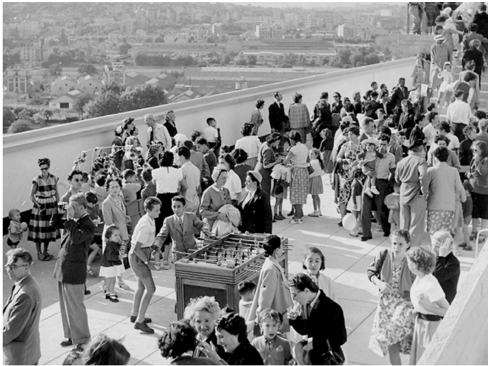
325. Fotografía de la cubierta comunitaria el día de la inauguración de la Unité d'habitation de Marsella
