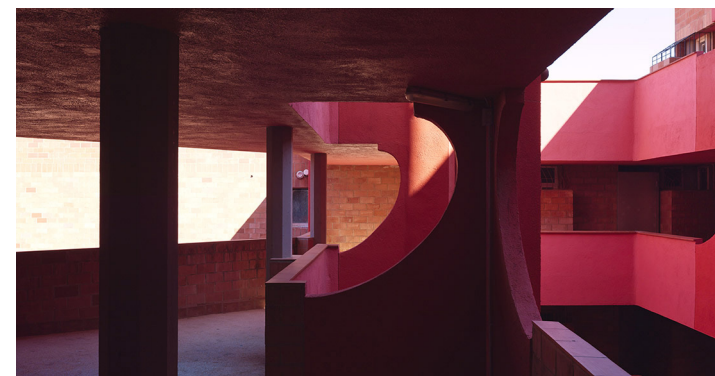
261. Fotografía de un segundo módulo del Barrio Gaudí, de Taller de Arquitectura. La disposición del espacio es la misma pero Taller de Arquitectura juega con el cambio de color para romper con la sensación de uniformidad en el proyecto
