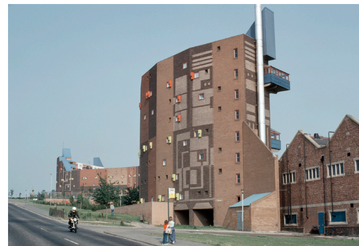
292. Fotografía de la fachada trasera de Byker Wall en donde Erskine juega ladrillos de distintos tonos para generar una fachada decorada que relacione el proyecto con las construcciones existentes en el lugar
