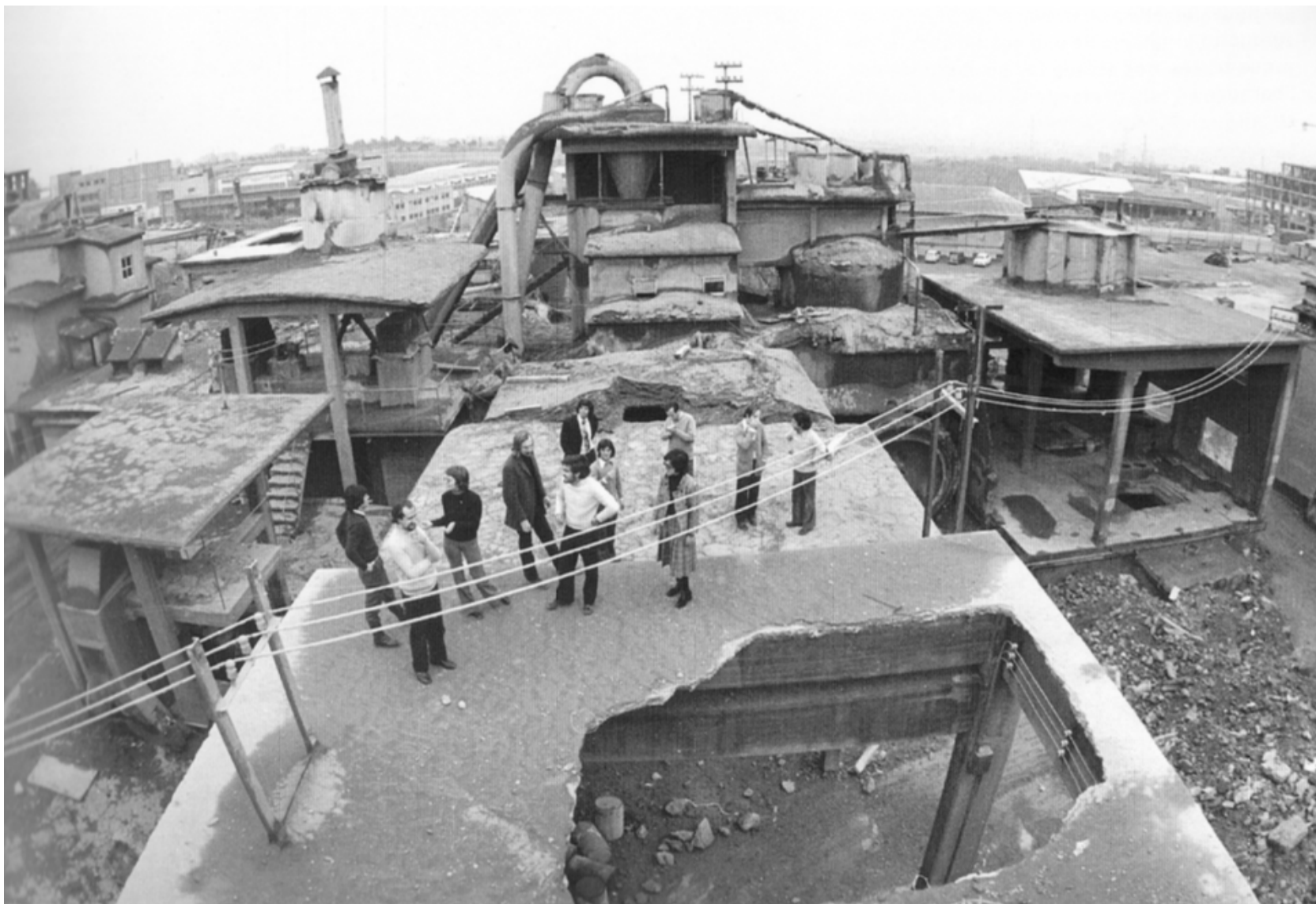
76. Los miembros del Taller sobre las ruinas de la fábrica la Sansón previo a su intervención
