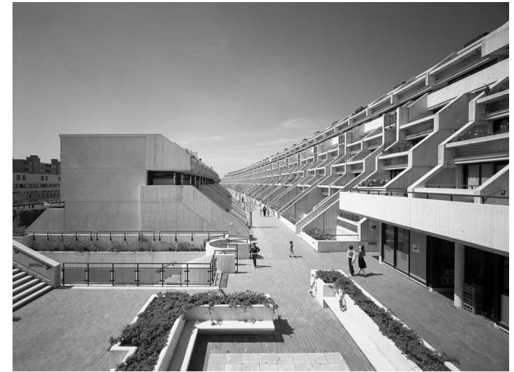
413. Fotografía del proyecto de Alexandra Road State en su finalización
