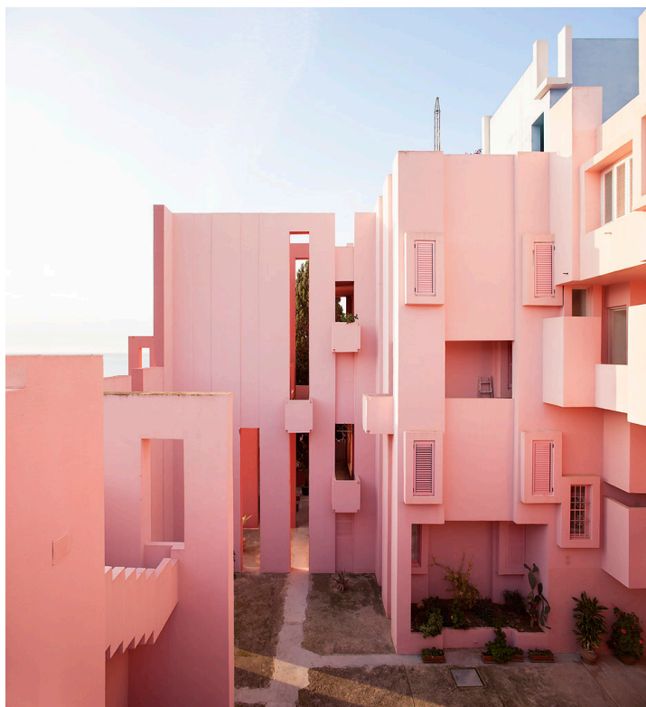
262. Fotografía de uno de los primeros patios de la Muralla Roja en Calpe, donde se aprecia las características de los espacios compartidos así como los juegos de las fachadas, el color y las decoraciones de estas
