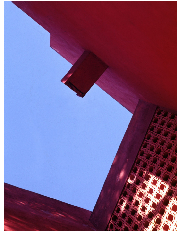
113. Detalle de las celosías de los apartamentos El Sargazo
