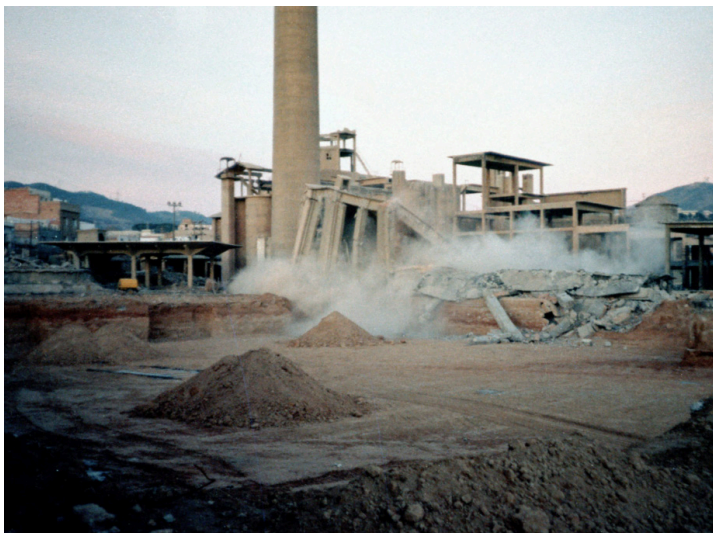
79. Fotografía de los trabajos de demolición en la Sansón
