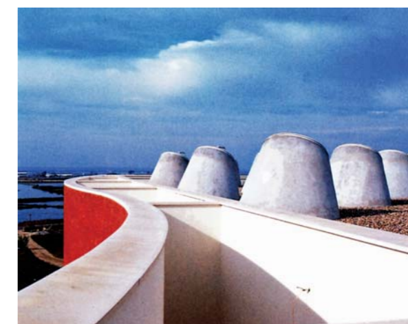
Fig. 3.42: SIZA, Álvaro – Centro de Informação Tecnológico (Biblioteca) , 1987/95. Fotografia dos lanternins da cobertura do edifício.
