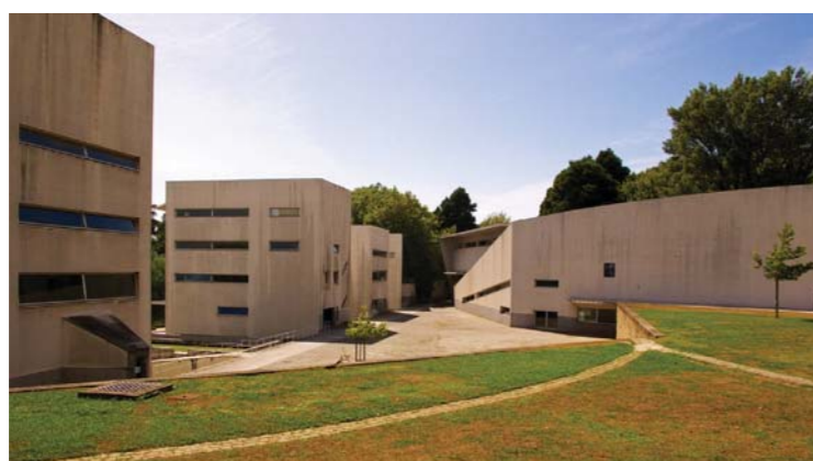
Fig. 4.49: SIZA, Álvaro – Faculdade de Arquitectura da Universidade do Porto, Porto, 1986/96. As torres isoladas garantem a vista sobre o Rio Douro a partir do espaço central.
