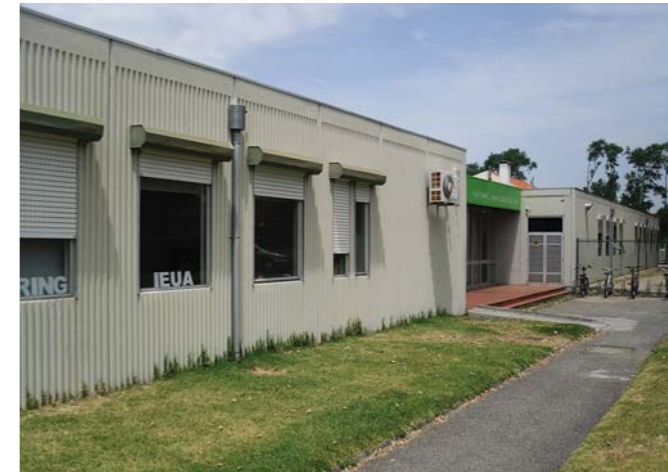
Fig. 0.5: VÉRTICE – Pavilhão I, 1977. Vista da zona da entrada.
