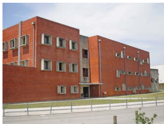
Fig. 5.50: CARVALHO, J. Kol – Departamento de Comunicação e Arte , 1991/96. Fachada sudoeste do edifício.
