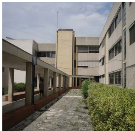
Fig. 2.19: REBELLO DE ANDRADE, Eduardo; SILVA, Armindo do Espírito Santo – Departamento de Electrónica e Telecomunicações , 1981/89. A localização dos acessos verticais do edifício comprometeram a fluidez do espaço-canal prevista no PGUAZ.
