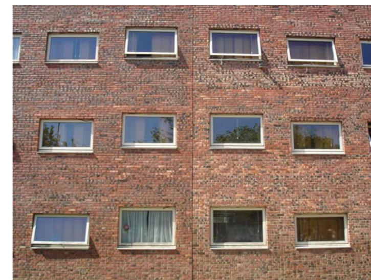
Fig. 3.29: DIAS, Adalberto – Residências de Estudantes , 1988/98. Repare-se no diferente posicionamento das janelas.
