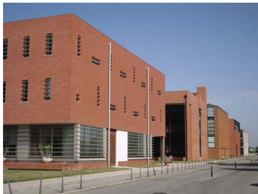
Fig. 4.71: Departamentos da Zona de Expansão Departamental Sul (ZEDS). A diversidade dos materiais das fachadas não impede uma percepção unitária do conjunto.
