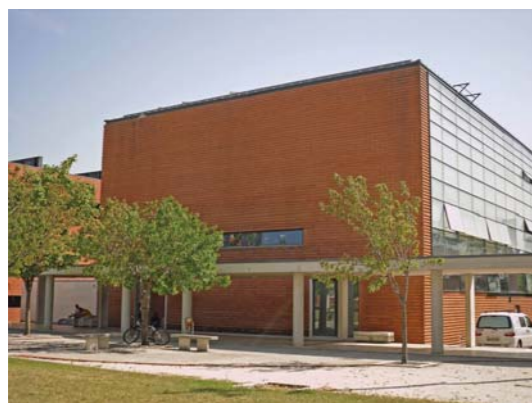
Fig. 5.29: DIAS, Adalberto – Departamento de Engenharia Mecânica , 1991/96. O edifício visto da Alameda.
