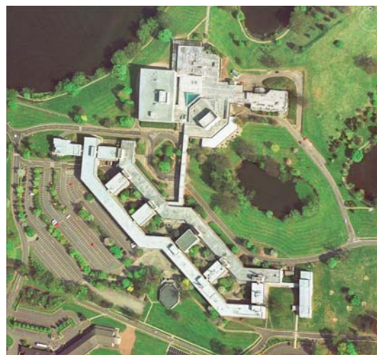
Fig. 1.31: MORRIS, James; STEEDMAN, Robert – Cottrell Building, Universidade de Stirling, 1966/70. Vista aérea do edifício.
