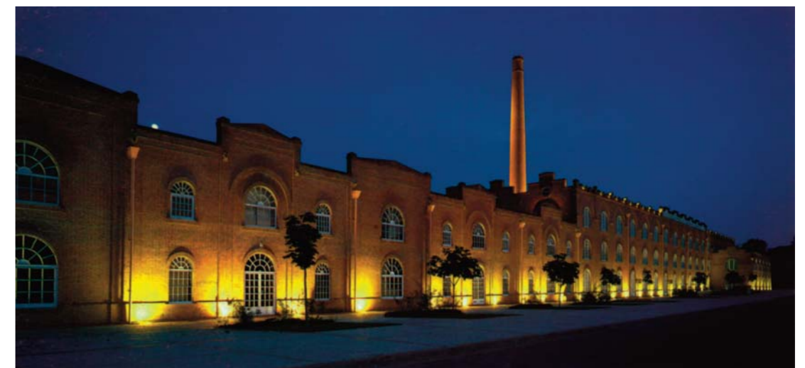
Fig. 3.45: OLÍMPIO, José Maria; OSÓRIO, António Crespo – Fábrica de Cerâmica Jeronymo Pereira Campos & Filhos (atual Centro Cultural e de Congressos), Aveiro, 1917 e 1990/95.
