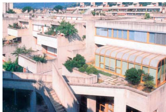
Fig. 1.63: De CARLO, Giancarlo – Villagio Matteotti , Terni, 1969/74. Vista geral do complexo com uma das passagens elevadas em primeiro plano.
