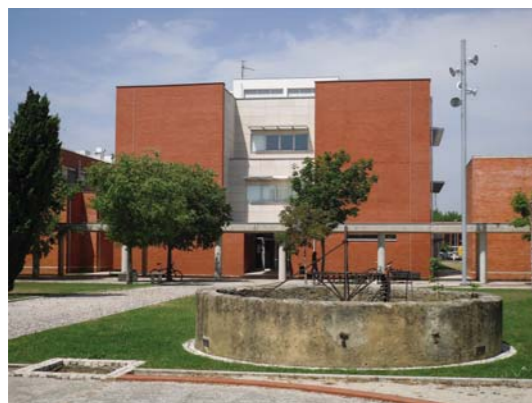
Fig. 5.38: ANDRADE, Eduardo Rebello de; FERNANDES, Luís – Laboratórios Tecnológicos / Complexo , 1999/06. O edifício visto da Alameda.
