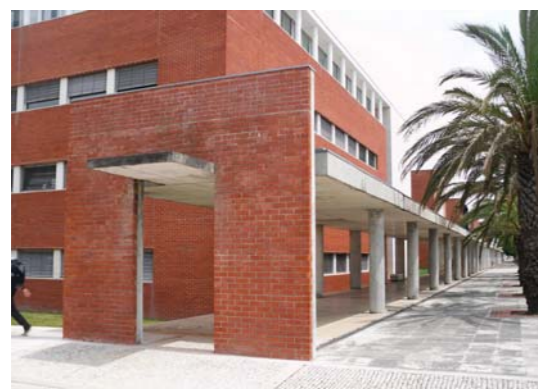
Fig. 6.20: ROBOREDO, Ana; OLIVEIRA, Joaquim, Galeria Envolvente dos Edifícios da Zona Sul do Campus Universitário , 1994/95. Vista do topo da Galeria.
