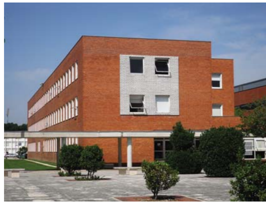
Fig. 5.2: RAMALHO, Pedro; RAMALHO, Luís – Departamento de Gestão e Engenharia Industrial , 1988/92. O edifício visto da Alameda.
