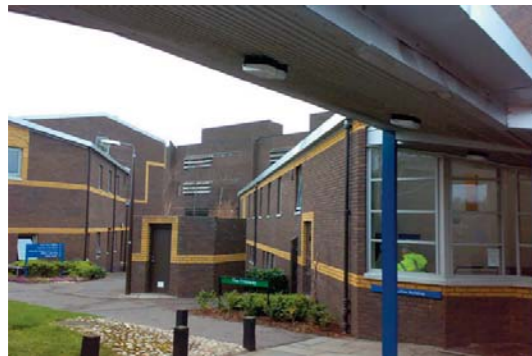
Fig. 1.29: REIACH, Alan; HALL, Eric and Partners – Riccarton Campus, Universidade de Heriot-Watt, Edimburgo, 1968. Aspeto do Campus.
