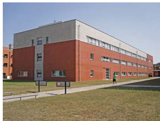
Fig. 5.39: ANDRADE, Eduardo Rebello de; FERNANDES, Luís – Laboratórios Tecnológicos / Complexo , 1999/06. Vista da fachada oposta à Alameda.
