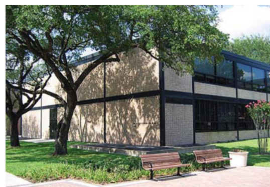
Fig. 4.46: JOHNSON, Philip – Universidade de St. Thomas , Houston, Texas. Os edifícios foram desenhados seguindo uma linguagem baseada na obra de Mies van der Rohe.
