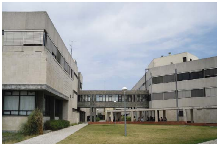
Fig. 3.12: SILVA, Gomes da; MENDES, Sousa (Hidrotécnica Portuguesa) – Departamento de Planeamento e Ambiente: Secção de Poluição , 1988/90. A imagem mostra o corredor elevado que une a Secção de Poluição (à esquerda) ao Departamento de Planeamento e Ambiente.
