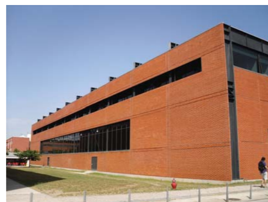
Fig. 5.42: OLIVEIRA, Joaquim – Secção Autónoma do Departamento de Engenharia Civil , 2000/04. Vista da fachada noroeste.
