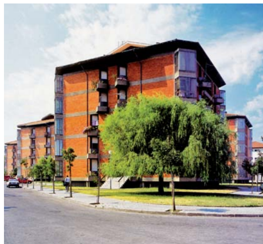
Fig. 3.46: LOUREIRO, J. Carlos; RAMOS, Pádua – Edifício de Habitação Colectiva "Torres Vermelhas", Aveiro, 1969/1972.
