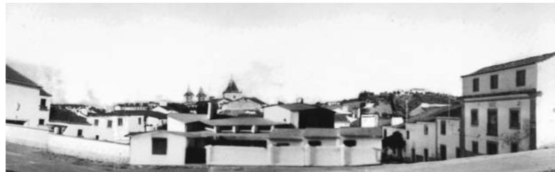
Fig. 3.2: PEREIRA, Nuno Teotónio; PORTAS, Nuno – Casa Dr. Barata dos Santos, Vila Viçosa, 1959/63. A casa desenvolve-se predominantemente na horizontal, assegurando a visibilidade do centro histórico.
