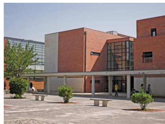
Fig. 5.27: PRATA, J. M. Lopo – Cefasi: Centro de Especialização e de Formação Avançada para os Serviços e Indústria, 1990/92. O edifício visto da Alameda.
