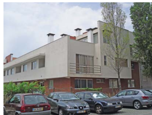
Fig. 7.15: Edifício de habitação coletiva na Rua B (Rua de São Tiago), Aveiro. O corpo superior rebocado e o envasamento em tijolo revela a preocupação de diálogo com os edifícios da Universidade.
