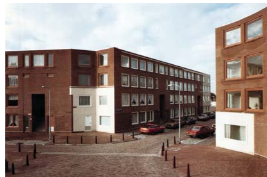
Fig. 3.51: SIZA, Álvaro – Edifícios de Habitação Social Punt und Komma , Schilderswijk-West, Haia, Holanda, 1983/88. Repare-se na conjugação, nas fachadas, dos mesmos materiais posteriormente utilizados na Biblioteca da UA.
