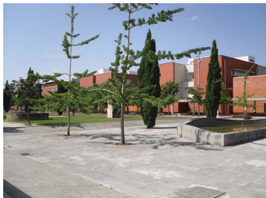
Fig. 4.67: Os departamentos oferecem uma leitura quase contínua de construção.
