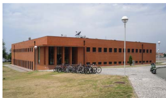
Fig. 6.8: PRATA, José Maria Lopo – IT – Instituto de Telecomunicações, 1991/93. Vista do edifício.
