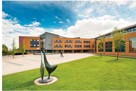
Fig. 1.38: Edifícios recentes da Universidade do Surrey.
