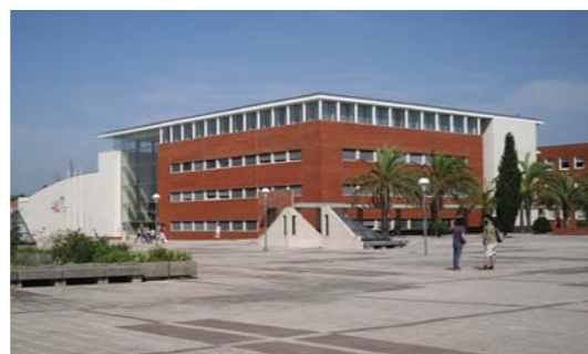
Fig. 5.78: BYRNE, Gonçalo; MATEUS, Manuel Aires – Edifício Central da Reitoria, 1992/2000. Vista do edifício desde a Praça Central.
