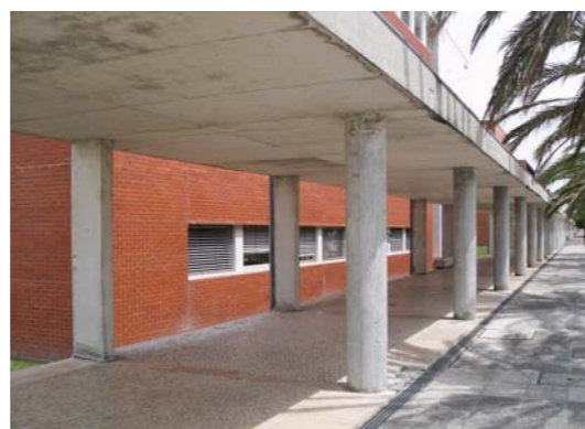
Fig. 6.21: ROBOREDO, Ana; OLIVEIRA, Joaquim, Galeria Envolvente dos Edifícios da Zona Sul do Campus Universitário , 1994/95. Vista do interior da Galeria.
