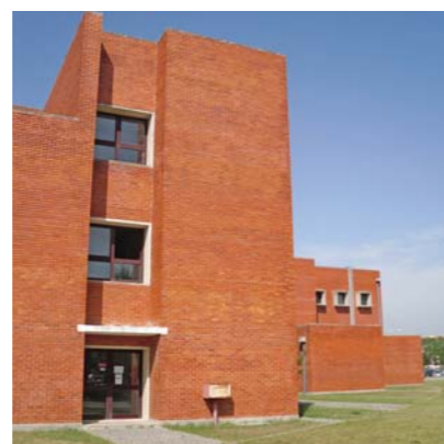
Fig. 5.55: CARVALHO, J. Kol – Departamento de Comunicação e Arte , 1991/96. Os remates dos extremos do "U" demonstram a difícil relação do edifício com o arruamento.
