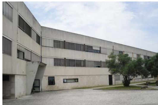
Fig. 3.8: TRABULO, Firmino / CEFA – Departamento de Planeamento e Ambiente, 1987/89. A inserção do departamento no conjunto foi uma preocupação basililar. À direita é perceptível a junta de dilatação que separa o edifício do vizinho Departamento de Electrónica e Telecomunicações.
