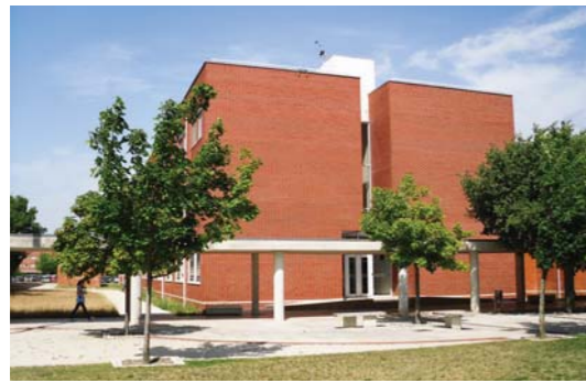
Fig. 5.8: FERREIRA, A. Matos; QUELHAS, Filomena – Departamento de Física, 1988/93. O edifício visto da Alameda.
