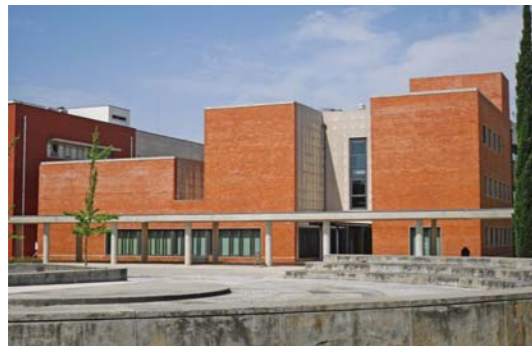
Fig. 5.11: SOUTINHO, Alcino – Departamento de Química, 1988/93. O edifício visto da Alameda.
