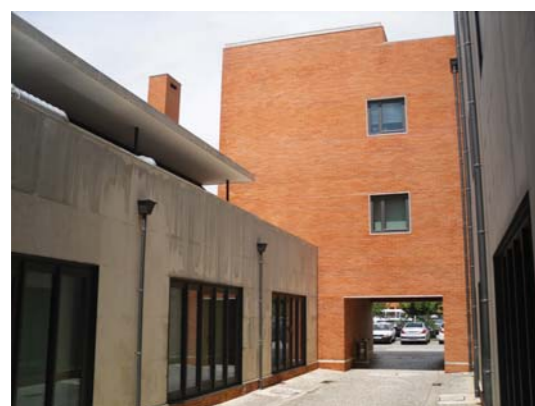
Fig. 5.15: SOUTINHO, Alcino – Departamento de Química , 1988/93. Vista do pátio.
