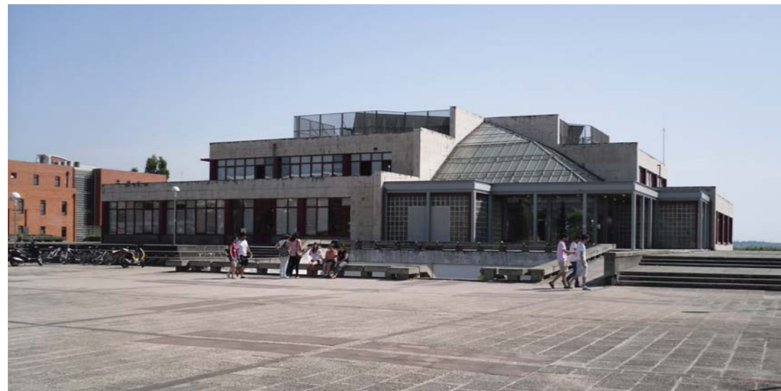
Fig. 2.25: REBELLO DE ANDRADE, Eduardo; SILVA, Armindo do Espírito Santo – Zona Técnica Central, Refeitório e Administração das Serviços Sociais , 1981/88. Vista do edifício do Refeitório e Serviços de Acção Social.
