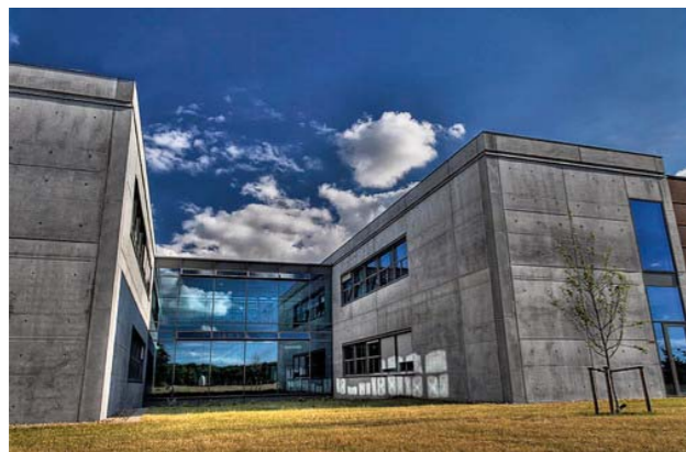
Fig. 1.22: HOLSCHER; KROHN; RASMUSSEN – Universidade de Odense, Dinamarca, 1971. Fachada em Betão Aparente.
