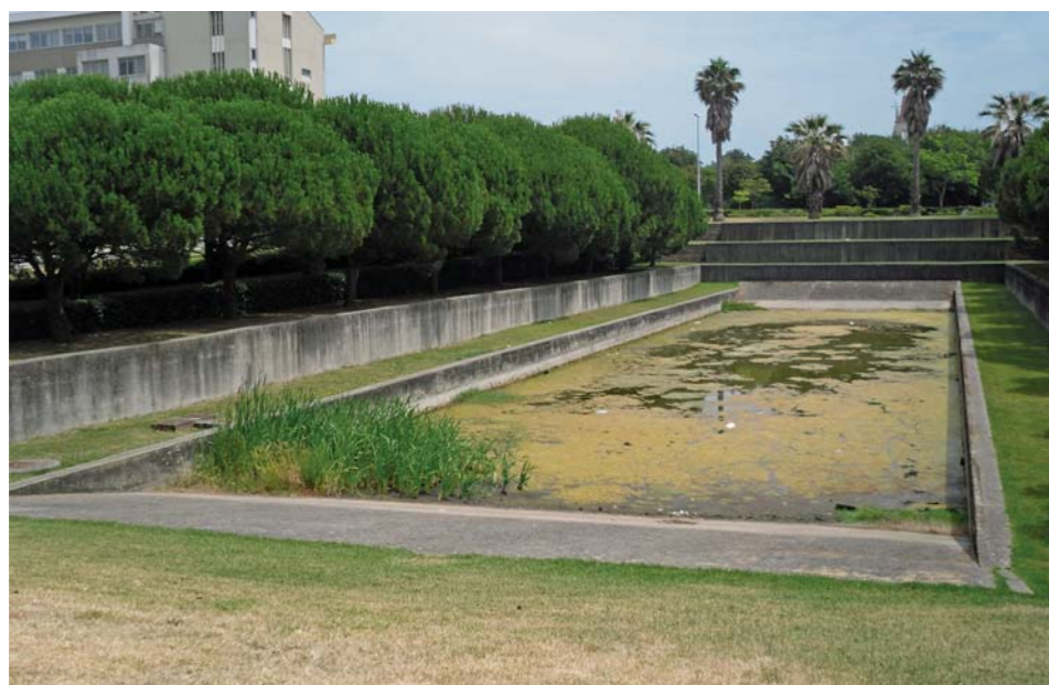
Fig. 6.16: SOUTINHO, Alcino – Plano de Arruamentos e Arranjos Exteriores , 1989. Vista da lagoa sanitária contígua ao Departamento de Engenharia Cerâmica e do Vidro, construída conforme o plano.
