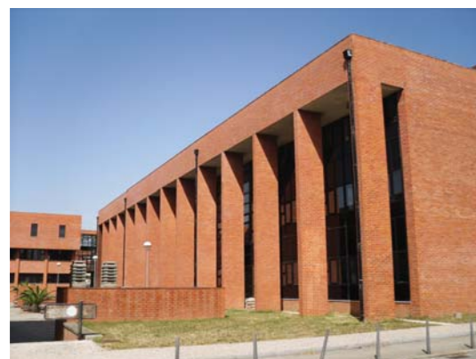
Fig. 5.26: PRATA, J. M. Lopo – Cefasi: Centro de Especialização e de Formação Avançada para os Serviços e Indústria, 1990/92. Fachada noroeste do edifício.
