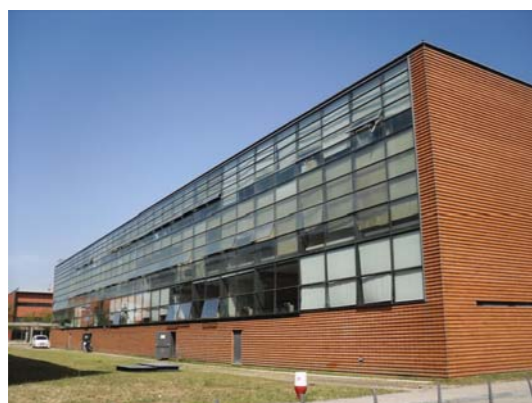
Fig. 5.31: DIAS, Adalberto – Departamento de Engenharia Mecânica , 1991/96. Vista da fachada noroeste.
