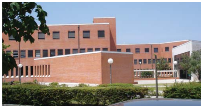
Fig. 3.18: LOUREIRO, J. Carlos; RAMOS, Pádua – Departamento de Biologia, 1987/92. Fachada orientada para a Rua A.
